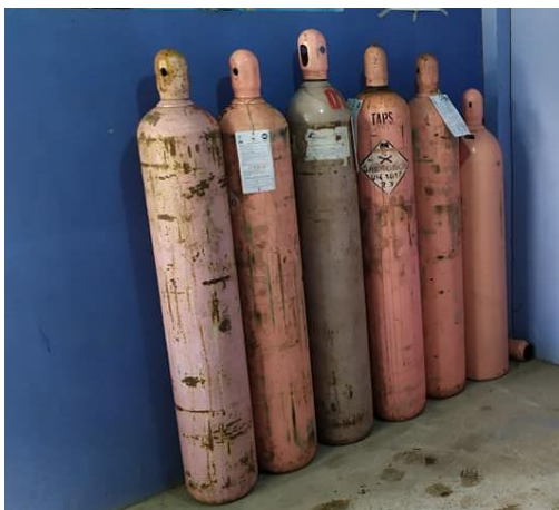
Figura 24. Cilindros de cloro gaseoso.
