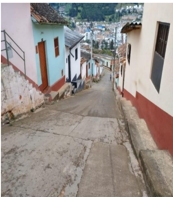
Ilustración 47 Terminación de la Loma de la Cruz
