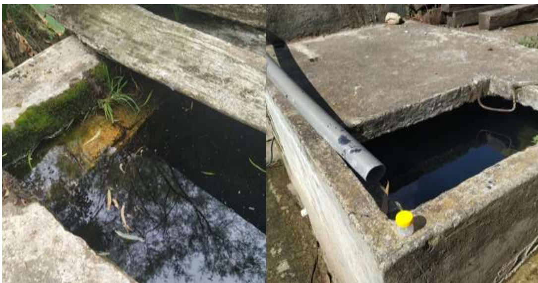
Figura 15. Tanques para el depósito de agua de los bebederos del ganado. (Fuente: Autor).
