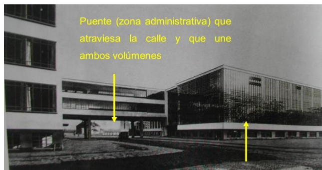
Figura 13. Elementos en fachadas
