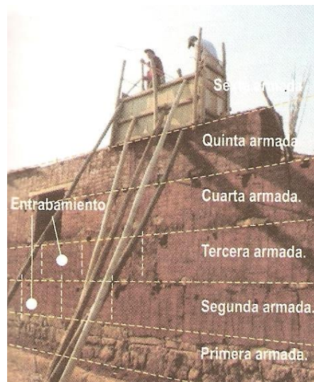
Gráfico 177: Armadas del Tapial para la construcción en tierra. Fuente: Arquitectura de tierra, sustentabilidad y cultura. Noviembre 2016.
