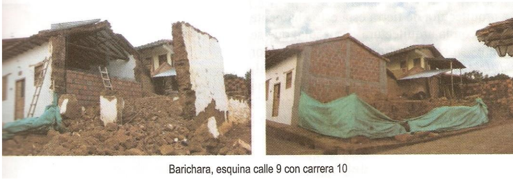
Gráfico 160: Esquina Calle 9 con Carrera 10, Barichara, Santander. Fuente: Arquitectura de tierra, sustentabilidad y cultura. Noviembre 2016.
