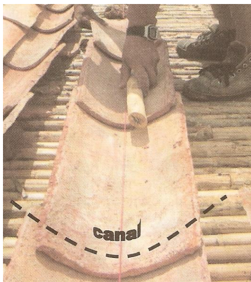
Gráfico 208: Instalación de la Teja de Barro.
