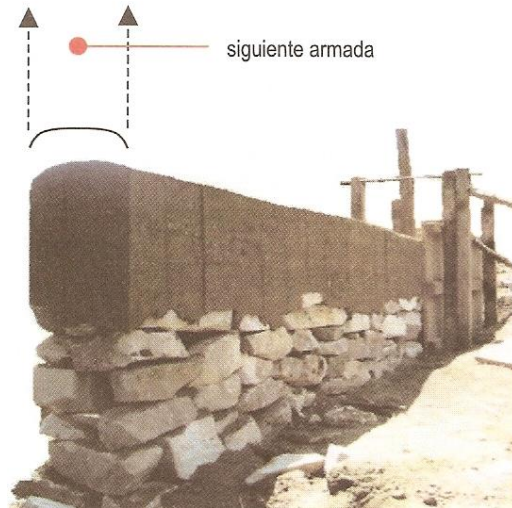
Gráfico 181: Muro de Tapia Pisada.
