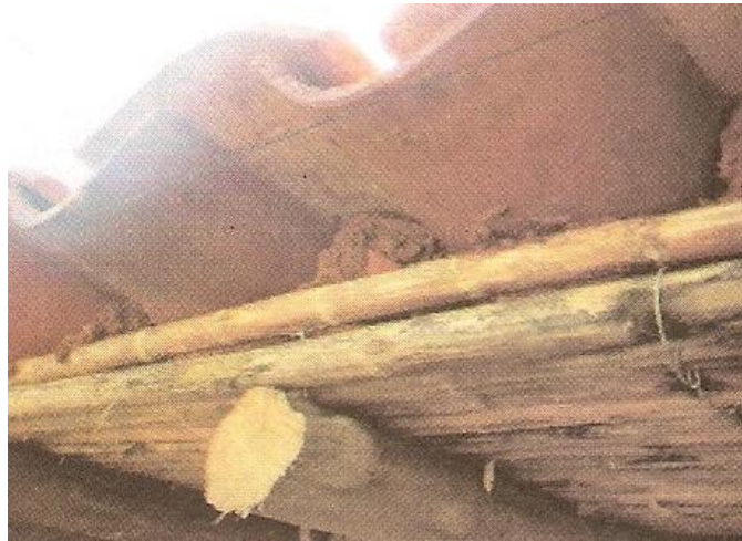
Gráfico 202: Instalación de la Caña-Brava.
