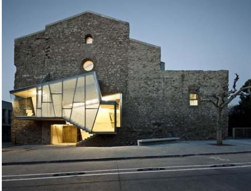
Gráfico 87: Ejemplo del concepto ad-herencia en intervenciones al patrimonio Fuente: Surroca, J.(2012). Convent de Sant Francesc . Recuperado de http://www.archdaily.com . Noviembre 2016.
