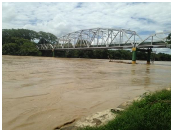
Figura 12. Estación hidrométrica convencional Puente Internacional Arauca
