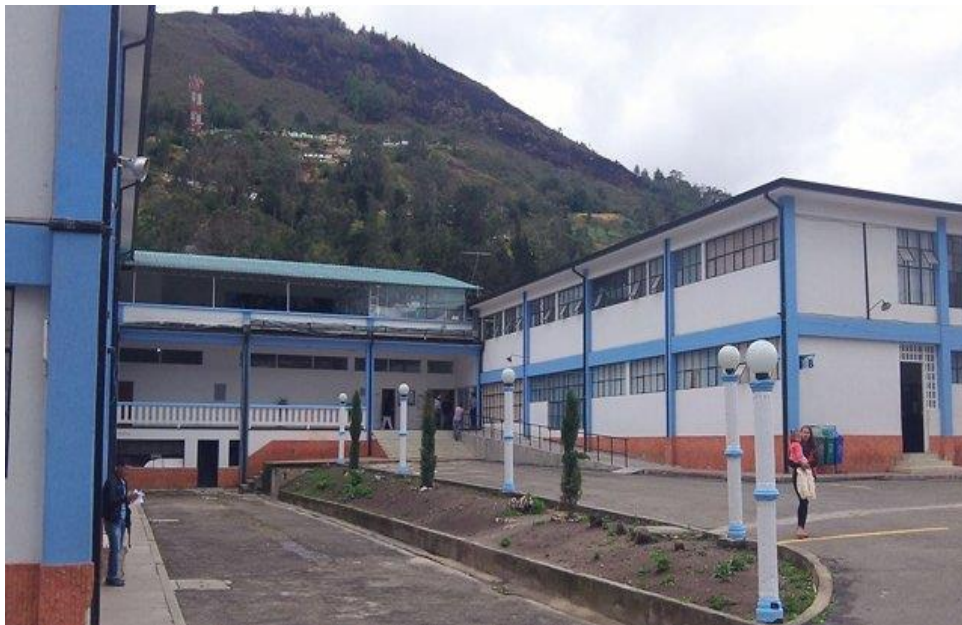
Figura 2. Fachada Del Hospital San Juan De Dios De Pamplona, Norte De Santander
