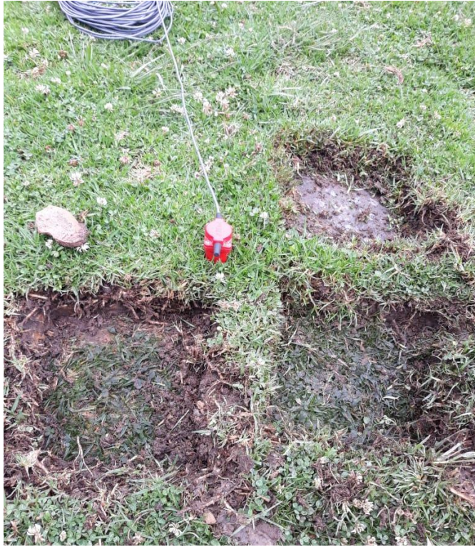
Imagen 13. Suelo saturado de agua.
