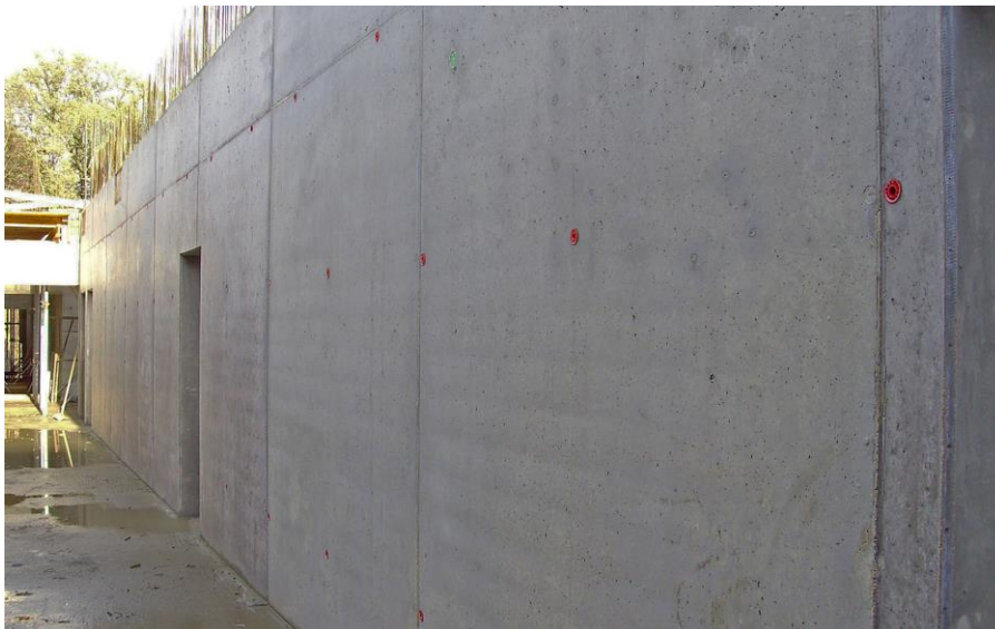
Figura 35 - Muro estructural en concreto a la vista Fuente: www.google.com
