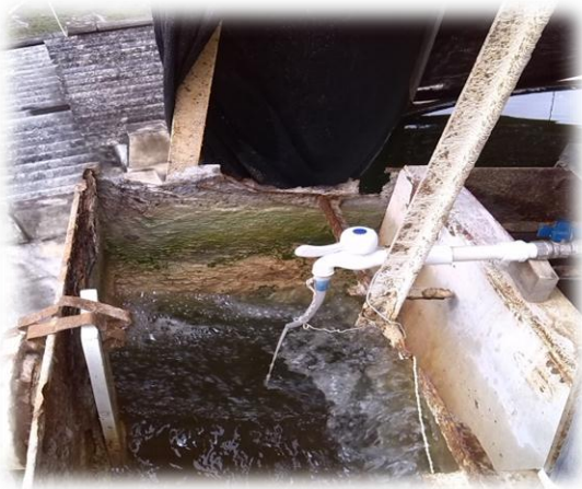
Imagen. No10. Llegada 18 L/s floculador. Imagen11. Pruebas hidráulicas PTAP.
