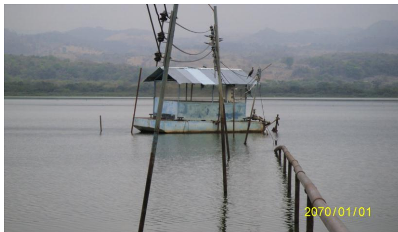
Imagen 2. Boca toma flotante.
