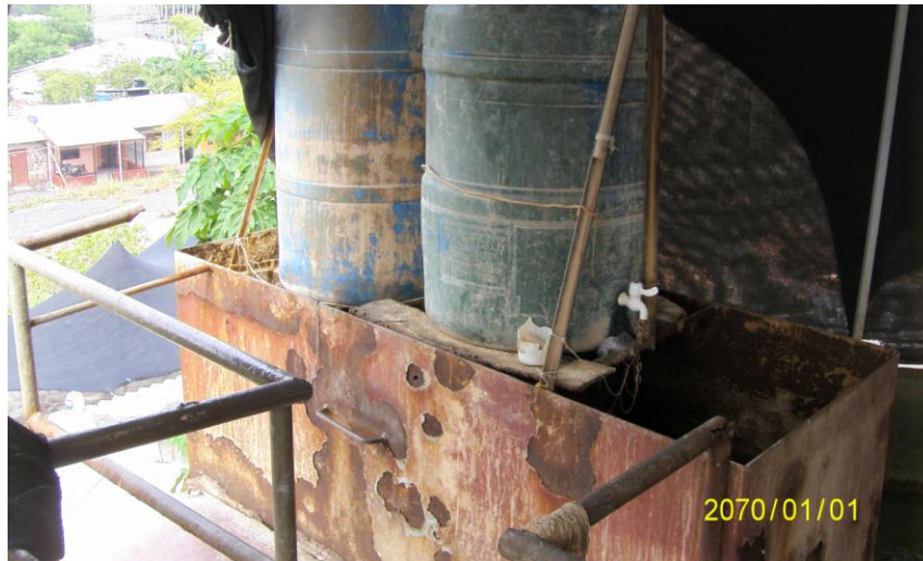
Imagen 3. Floculador flujo horizontal.
