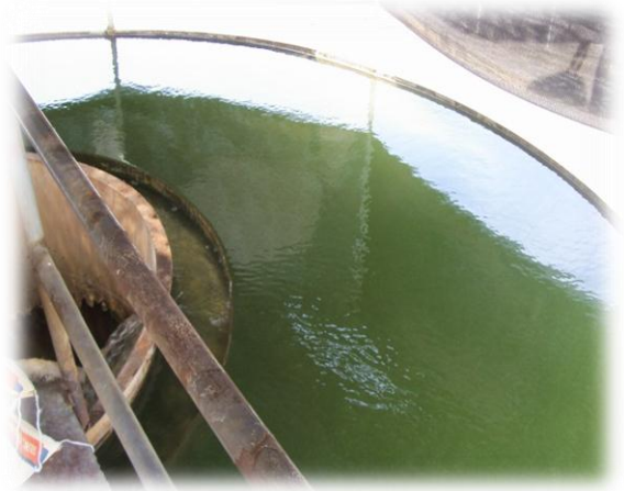
Imagen. No10. Llegada 18 L/s floculador. Imagen11. Pruebas hidráulicas PTAP.
