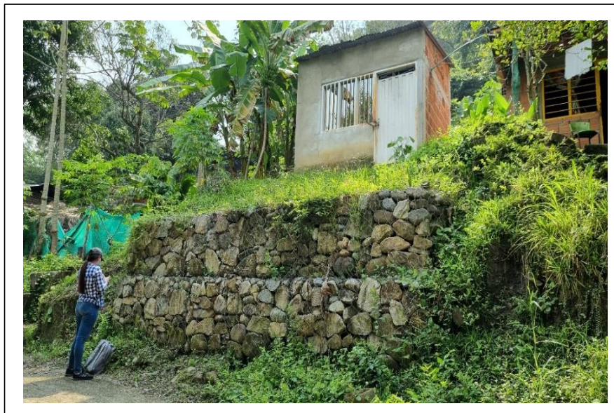
Figura 16. Fotografía obras ingenieriles (gaviones), sobre el barrio la Cruz.
