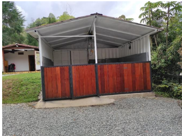
Figura 5 Quirófano Internal MV
