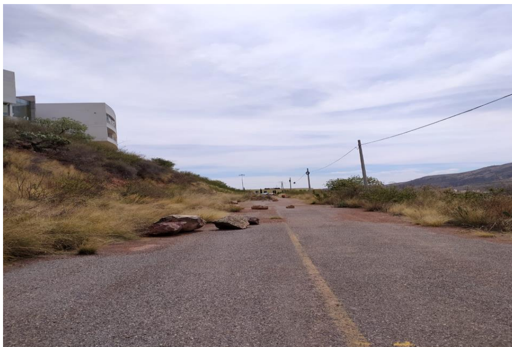
Figura 41. Caída de rocas de aproximadamente 100 metros de longitud.
