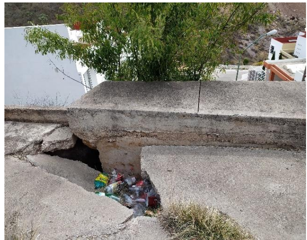
Figura 22. Huecos en el muro
