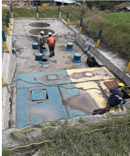
**Figura 14** pozo séptico mina Incarsa S.A.S
