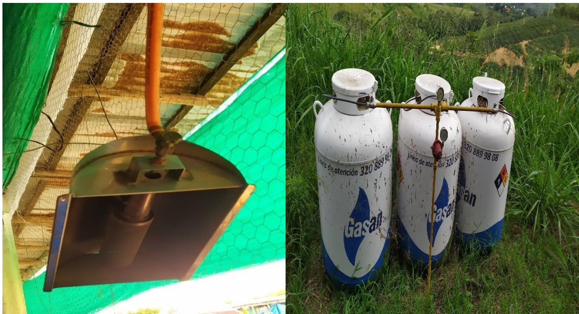
Imagen N°3. Calefactor y pipetas de gas.
