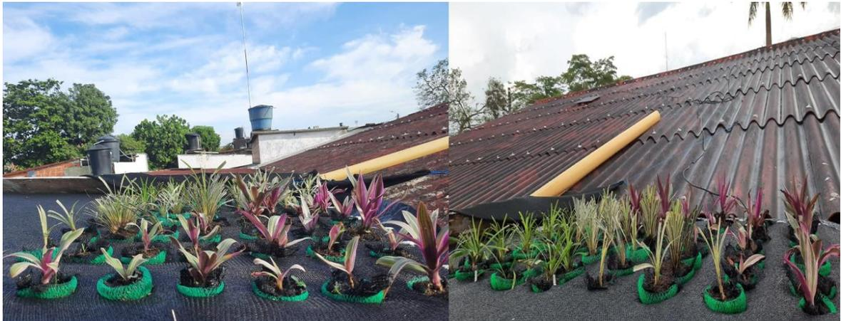
*Figura 13. Cubierta verde con 1 mes de adaptación*
