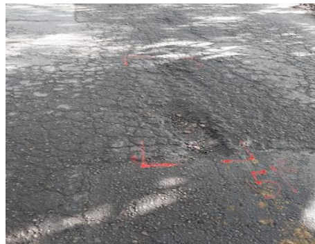
Reparcho de pavimentos
