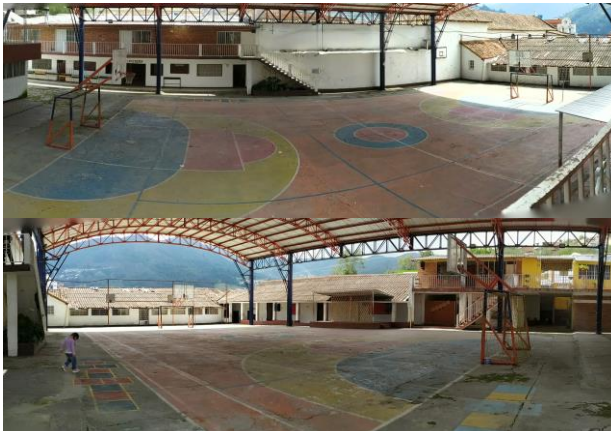
Cancha múltiple sede Afanador. Tomada por Juan Carlos Ordóñez Bermejo, 2021.
