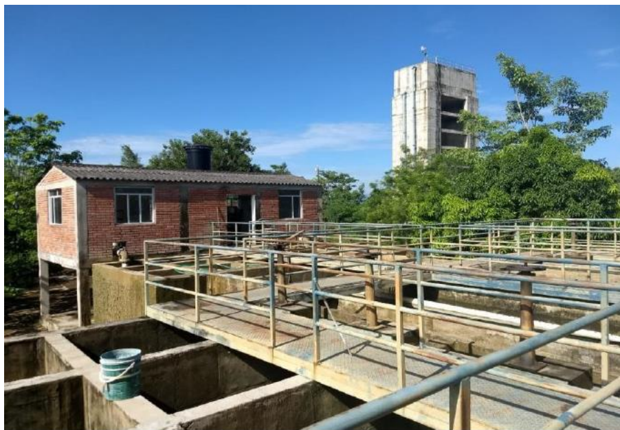
Imagen 7. Planta de tratamiento, tanque de almacenamiento.
