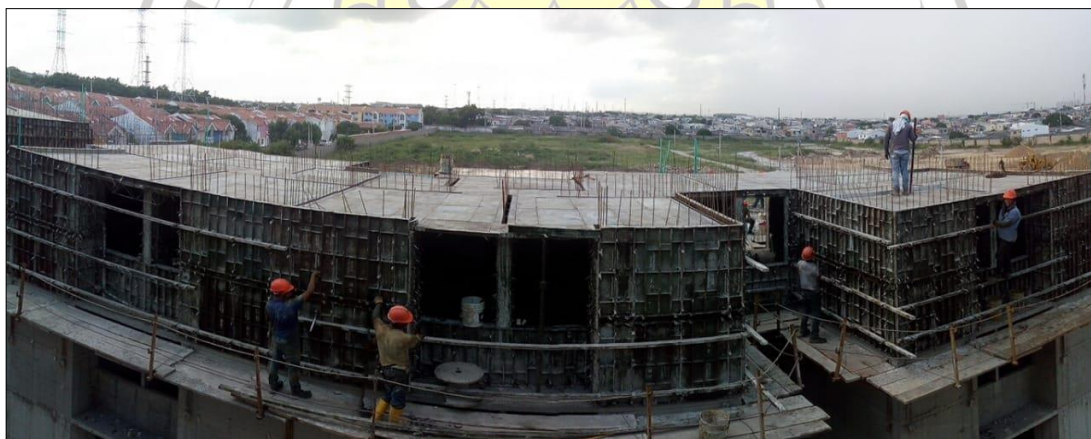
Imagen N°10. Fundida de apartamentos (Muros y losa).
