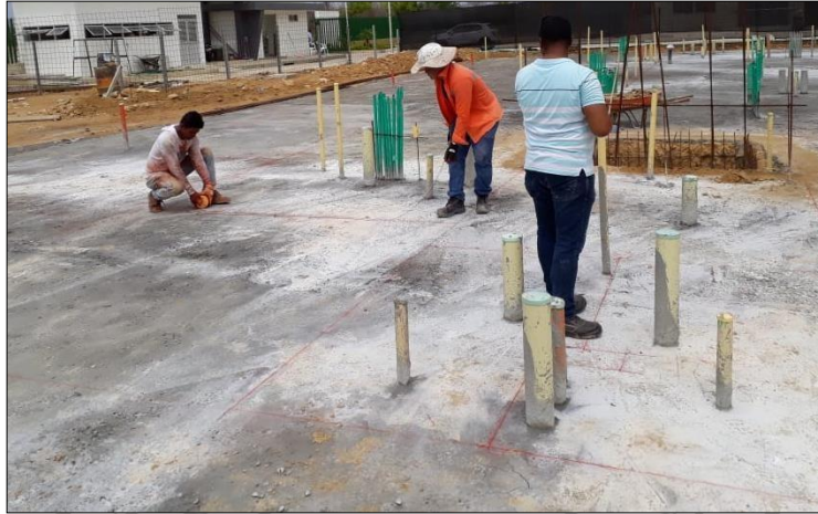
Imagen N°03. Cimbrado de terraza.
