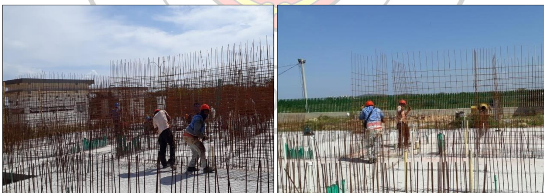
Imagen N°08. Instalación de mallas de refuerzo.
