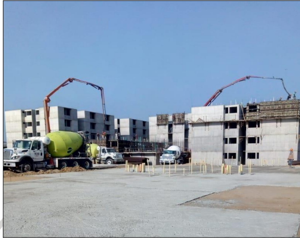
Imagen N°11. Fundida de apartamentos (Muros y losa).
