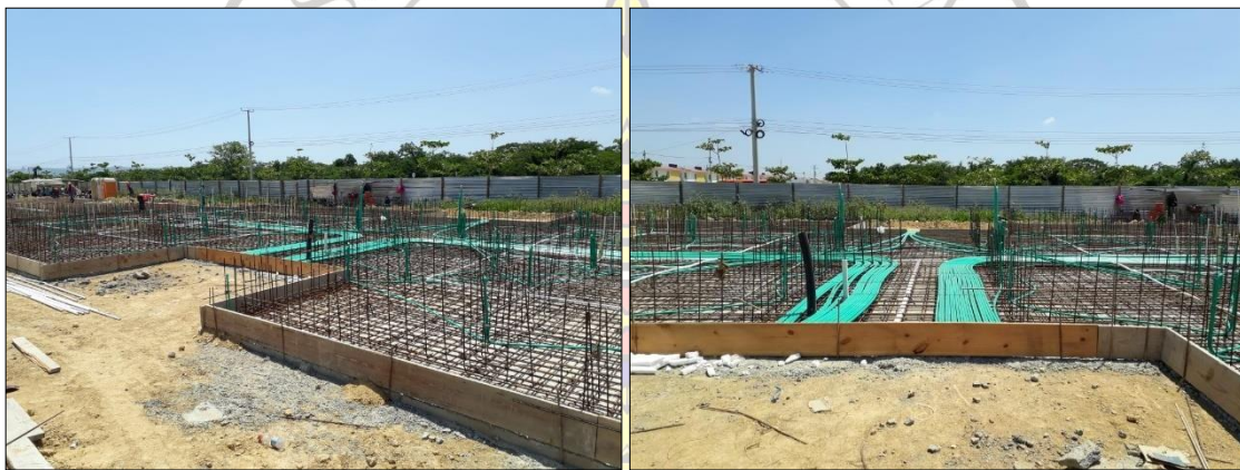
Imagen N°05. Instalación de tuberías hidráulicas y eléctricas.
