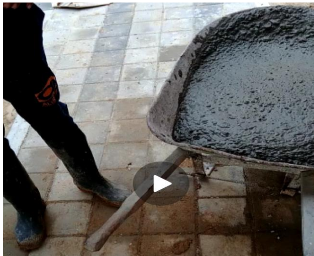
Figura 12. Vaciado del concreto sobre la carretilla (Fuente propia)
