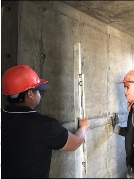
Imagen N°14. Revisión de muros.
