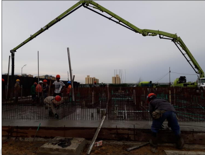
Imagen N°06 Fundida de losa de cimentación.
