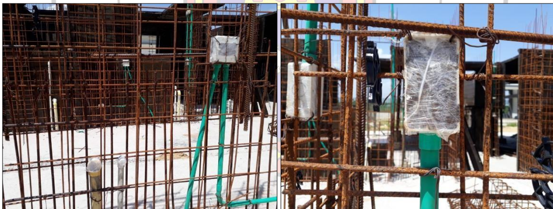
Imagen N°09. Puntos hidrosanitarios y eléctricos con Icopor y papel Vinipel.
