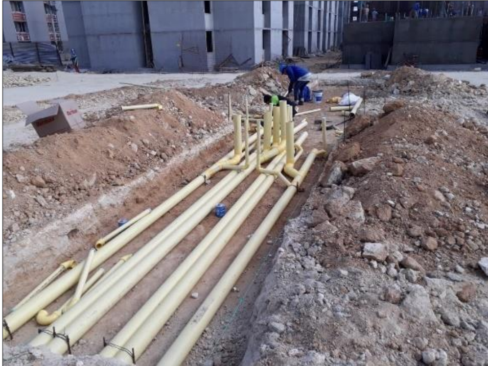
Imagen N°01. Instalación de tuberías sanitarias.
