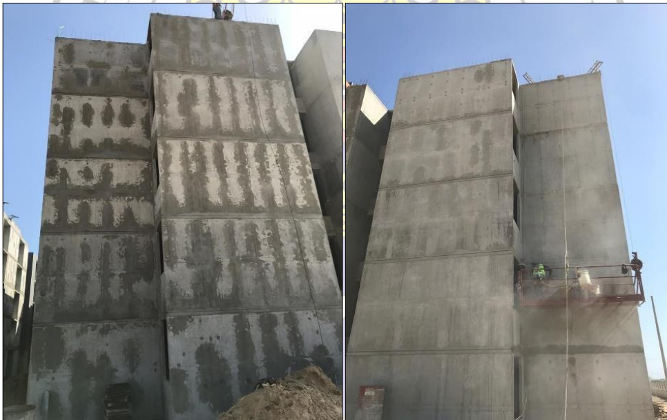
Imagen N°16. Pulida de fachada.
