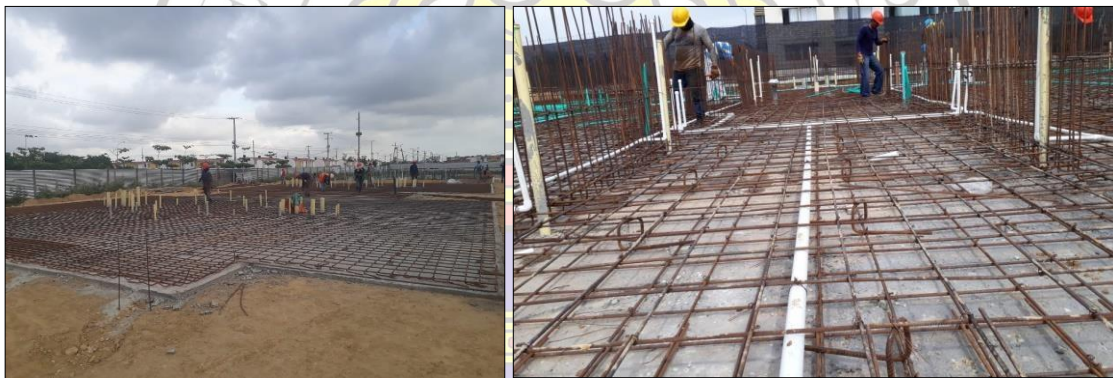
Imagen N°04. Armado de la parrilla inferior- Arranques de aceros de muros.
