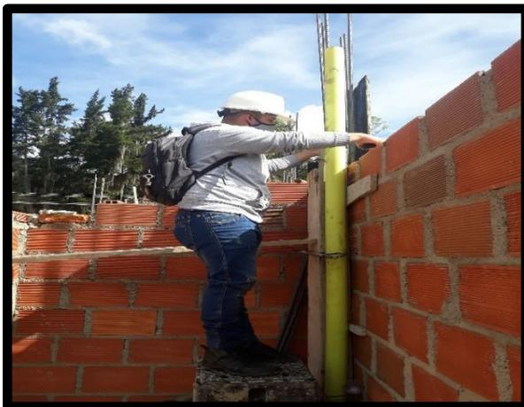
**Figura 16: Fundida de columna C-4.**
