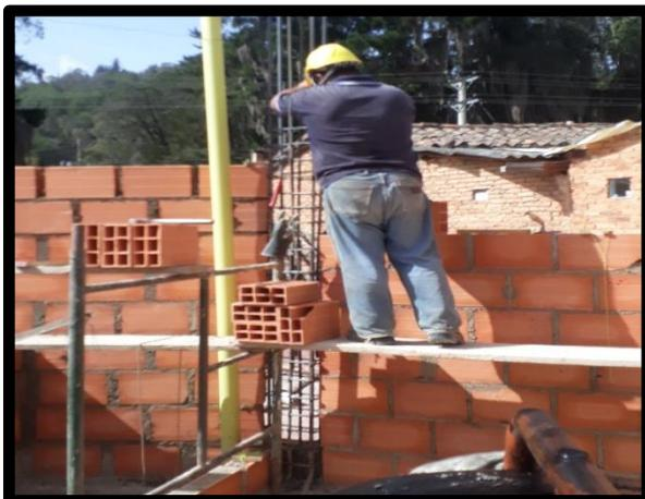
**Figura 18: Verificación de los estribos.**
