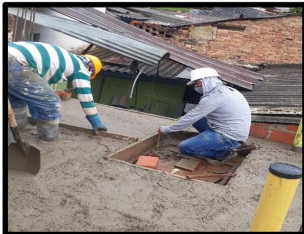
**Figura 31: Vibrado de la losa de entre-piso.**
