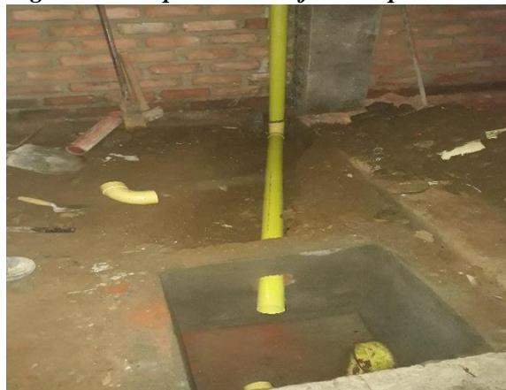
**Nota:** Basándonos en la NSR-10 en el título C.6.3, se acordó con el ingeniero estructural que el paso de tuberías sanitarias solo se realizarían por nervios secundarios para de esta manera no afectar el correcto funcionamiento de la estructura.
