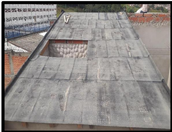
**Figura 43: Instalación de la teja tipo shingle.**
