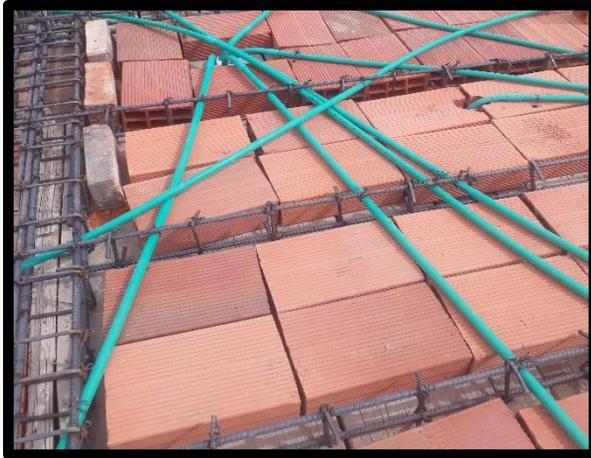
**Figura 45: Instalación de puntos eléctricos.**
