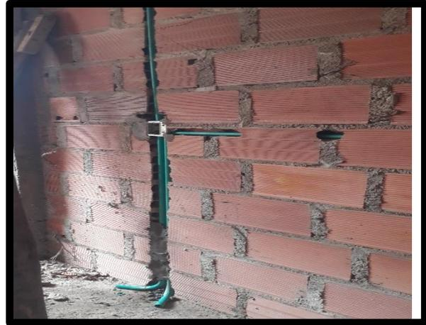
**Figura 46: Instalación de tubería del gas.**
