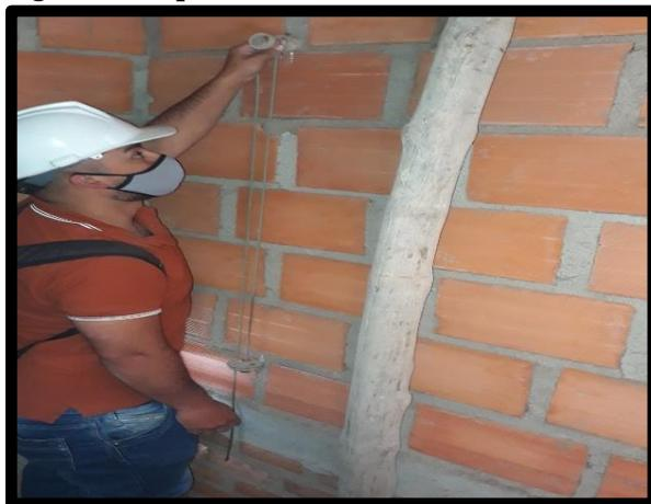
*Figura 20: Replanteo de los muros en bloque.*
