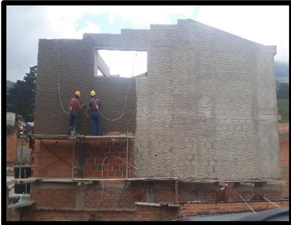
Para garantizar una buena ejecución de la actividad de reboque se tubo en cuenta una supervisión constante, con el uso de la plomada y el nivel de mano corroborando la buena terminación del pañete, para posteriormente dar paso a las terminaciones de estuco y pintura; también se tubo en cuenta la cantidad de agua con relación al cemento siendo uniforme y permitiendo la obtención de una pasta consistente que no se deforme al ser aplicada.
