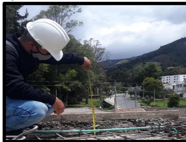
**Figura 30: Verificación del recubrimiento.**
