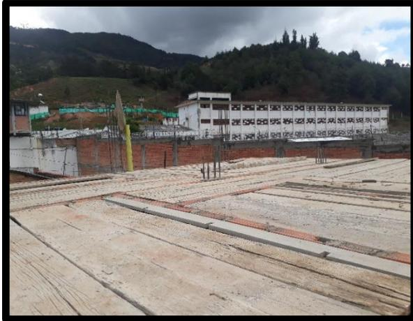
**Figura 23: Encofrado de la placa de entre-piso.**
