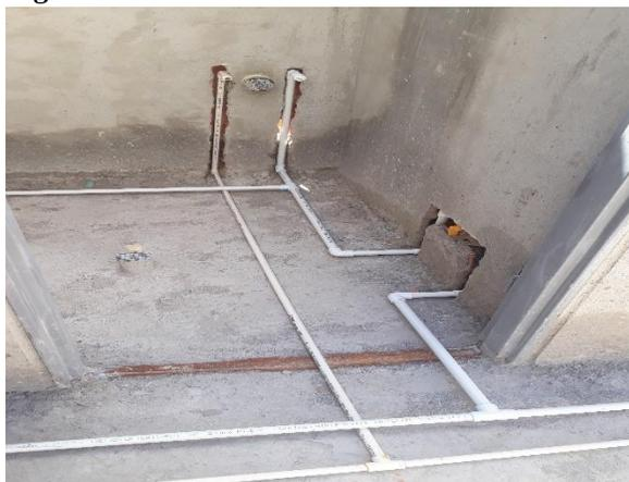
***Figura 59: Verificación de las tuberías.***
