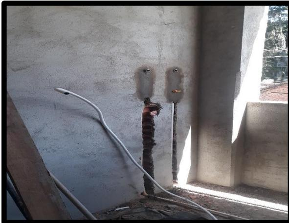
**Figura 47: Instalación de tubería del gas.**
