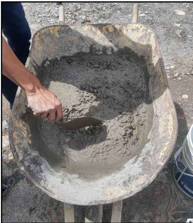
Figura 25: Mezclado De Los Materiales De M-1.
