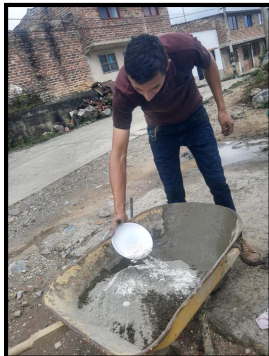
Figura 32: Adición De Oxido De Calcio.
