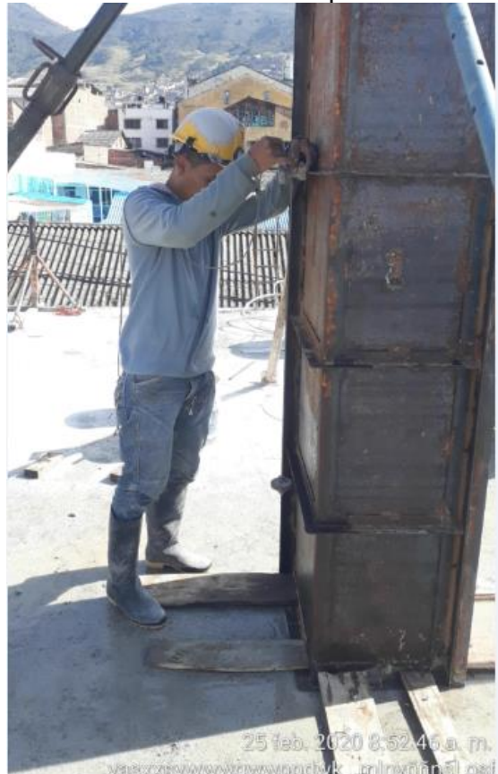
Nivelación de formaletas para columnas
