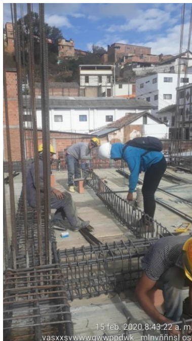
Figura 29 Verificación de medidas de estribos en viguetas
