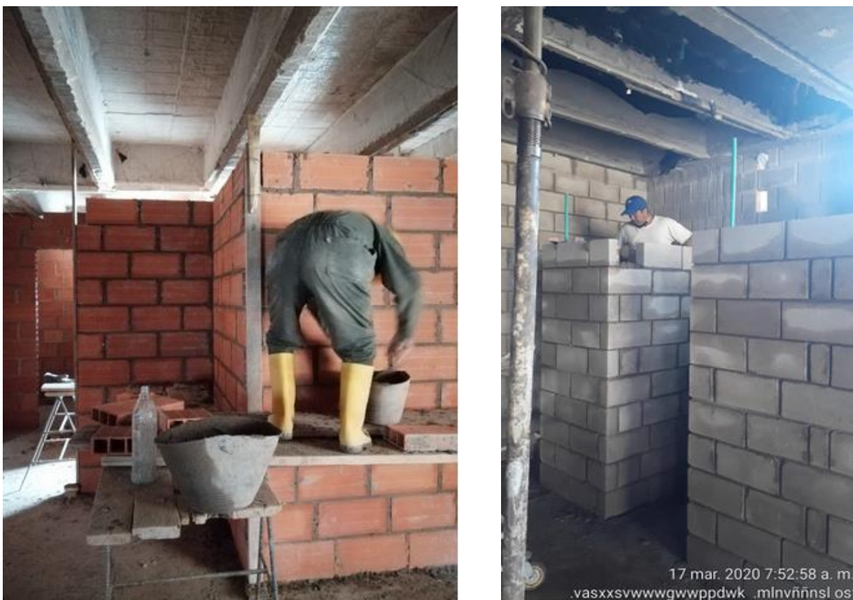
Figura 26 Levantamiento de muros divisorios
