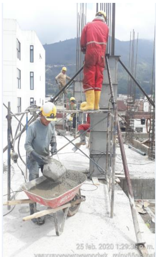
Fundida de columnas
