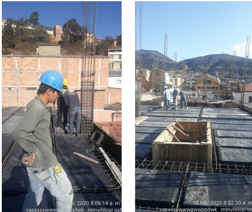
Figura 28 Instalación de casetones
