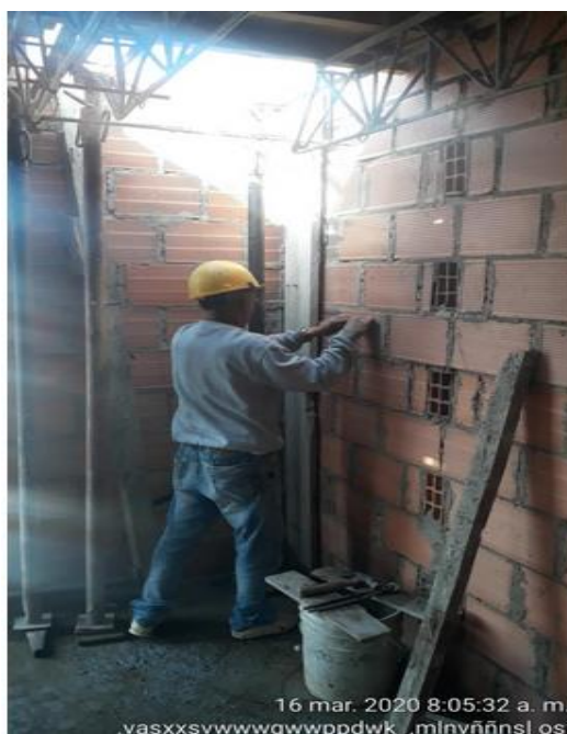
Figura 27 Encofrado de columnas de amarre
