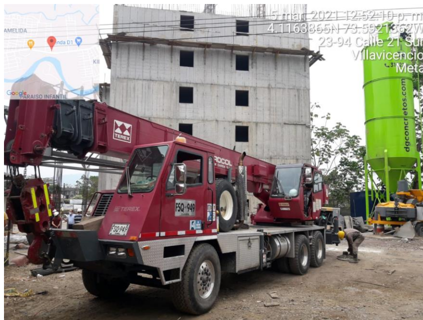
Ilustración 24 Instalación de concretera en obra. (Fuente propia)
