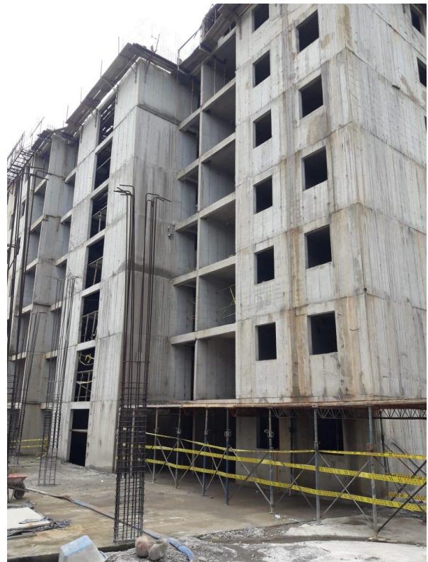
Ilustración 22 Ejecución en finalización de pasantías. (Fuente propia)
