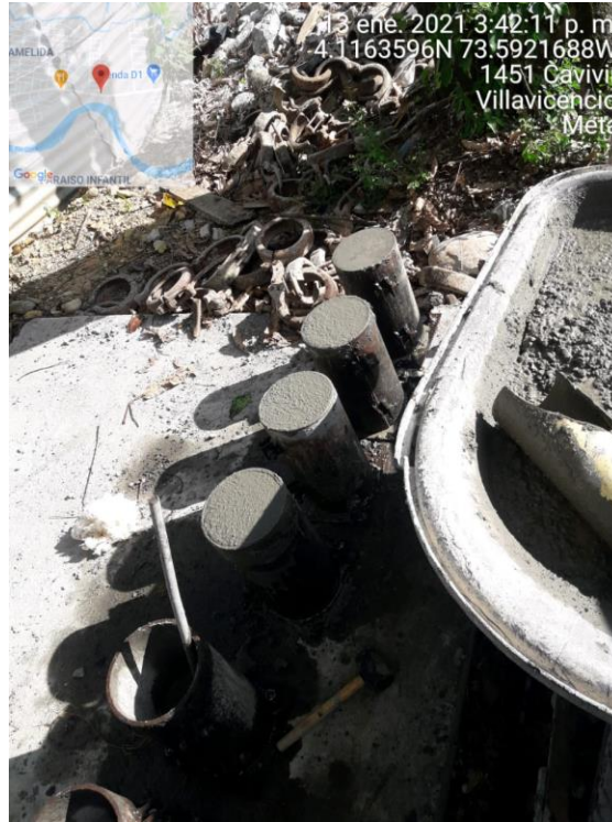
Ilustración 19 Realización ensayo de resistencia del concreto (Fuente propia)
