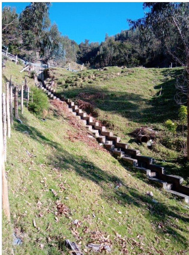
Figura 25. Obras civiles para minimizar la amenaza por erosión hídrica
