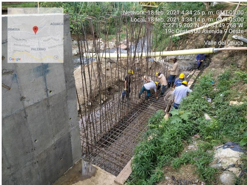
Al terminar el armado de la zapata y el dentellón, se continúa con el armado del refuerzo que tendrá el vástago. Fuente: Autoría propia.
