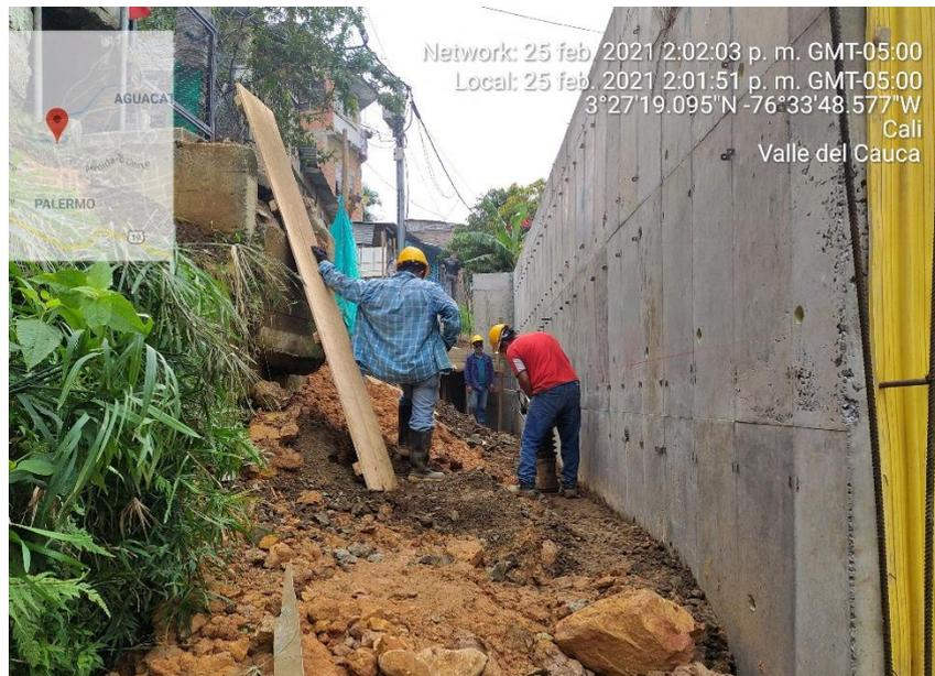
Para agilizar el avance de la obra se procede a utilizar material sobrante de las excavaciones para usarlo como relleno. Fuente: Autoría propia.
