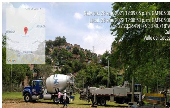
Al llegar el camión mezclador y el brazo hidráulico se realiza instalación de la manguera para hacer llegar el concreto hasta el muro formateado. Fuente: Autoría propia.
