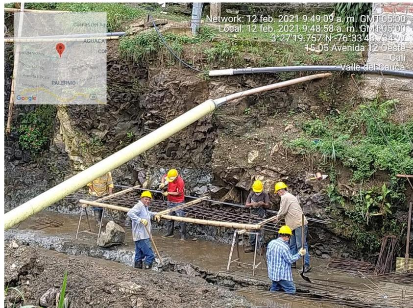
Para realizar el tramo 2 del muro de contención, se comienza el amarre de acero de la zapata.
