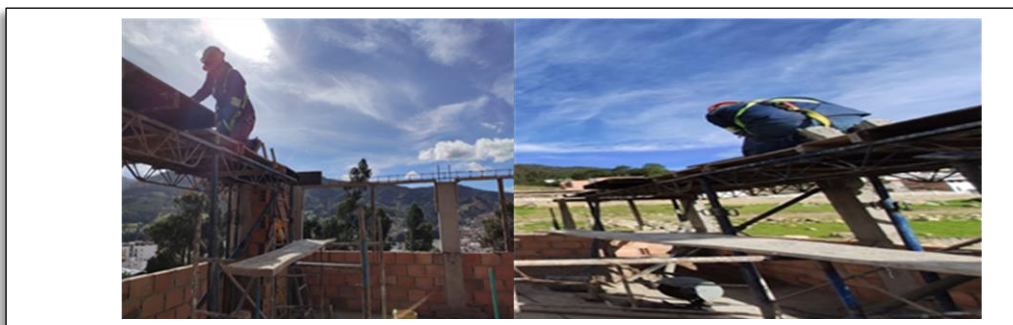
Viga Canal 4to Piso
