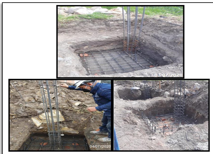
Acero de Zapatas
