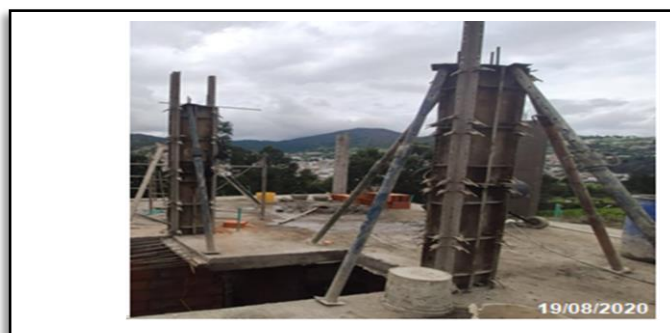
Encofrado Columnas 3er Piso
