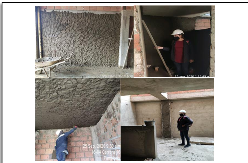
Pañete Sótano Y 1er Piso
