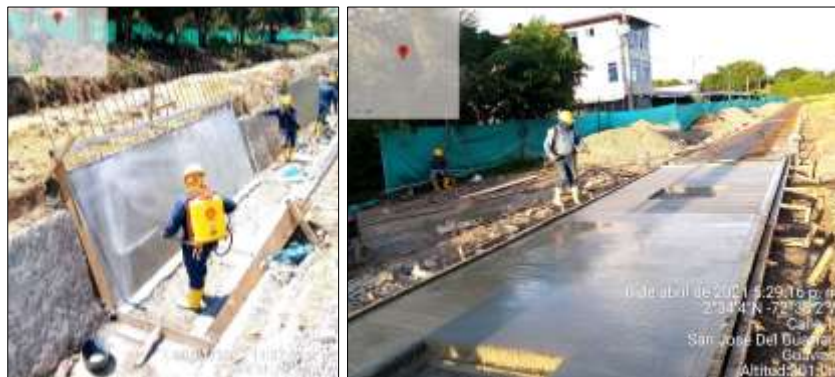
Ilustración 31: Aplicación de anti sol a losas fundidas
