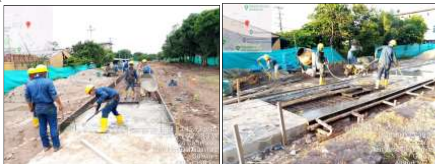
Ilustración 30: Aplicación de vibrado a la mezcla de concreto
