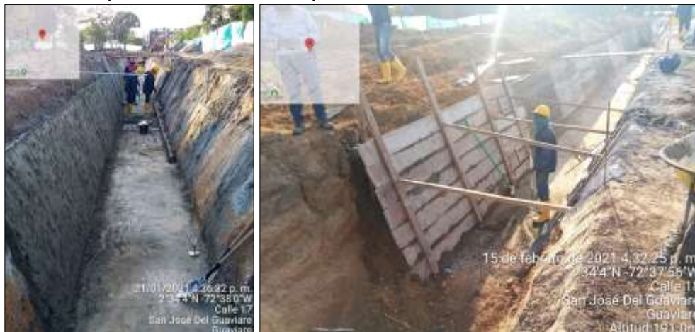
Ilustración 27: Aplicación de concreto 2500psi, solado de la canal
