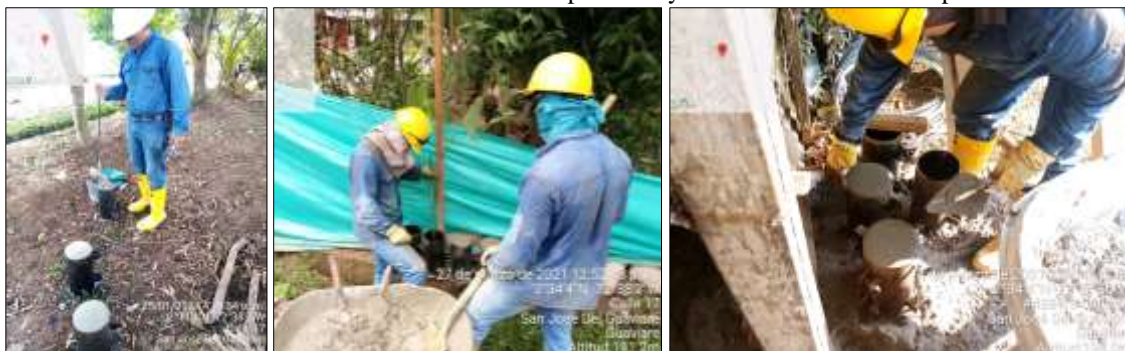
Ilustración 32: Toma de muestra para ensayo de resistencia a la compresión
