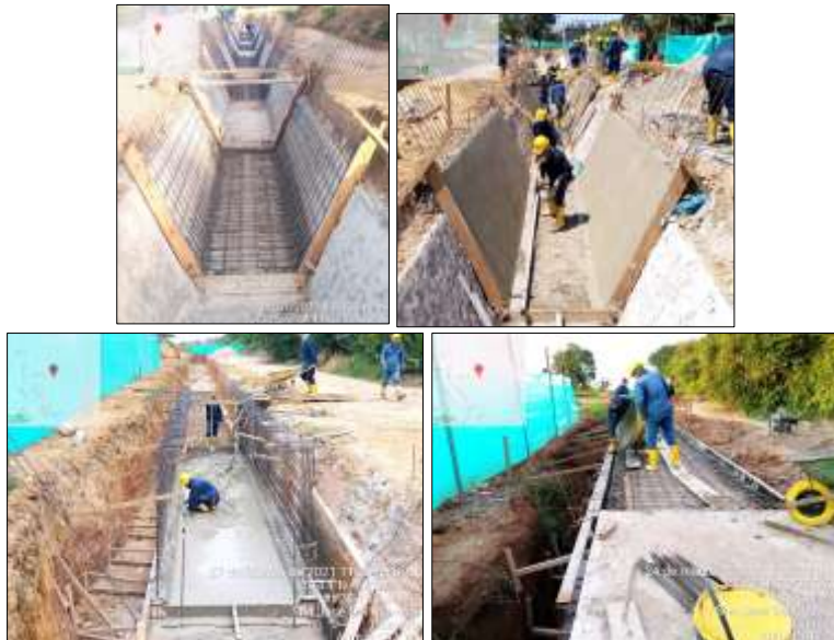
Ilustración 28: Aplicación de concreto de 4000psi impermeabilizado
