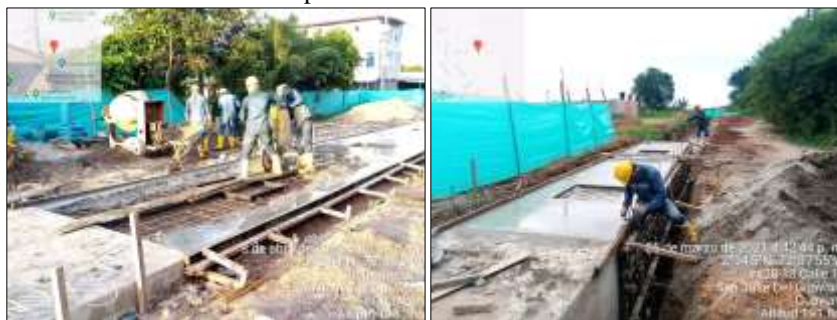
Ilustración 29: Aplicación de concreto de 3000psi
