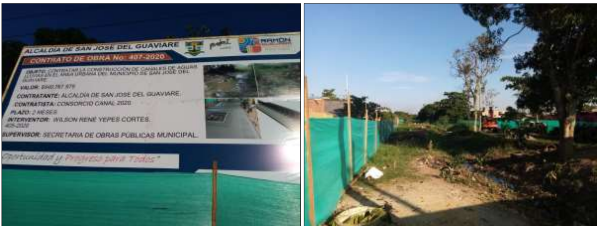
Ilustración 7: Primera visita de obra. Verificación de avances
