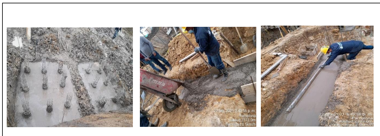
Figura 18 Concreto de saneamiento
