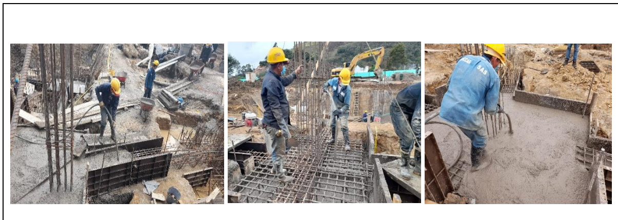
Figura 29 Procedimiento de fundida de cabezales
