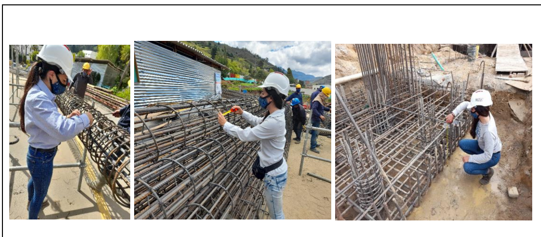
Figura 22 Seguimiento de obra
