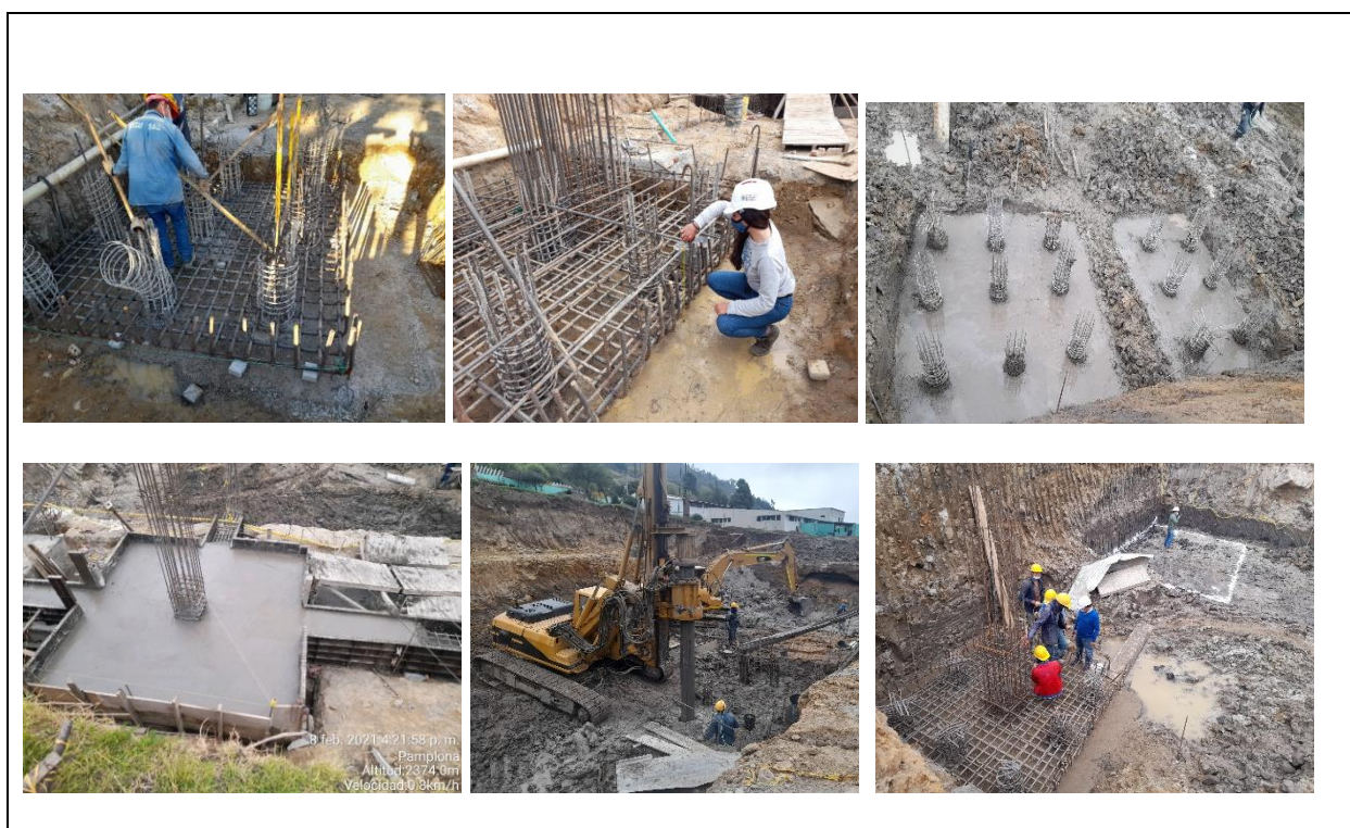
Figura 12 Actividades ejecutadas séptimo corte
