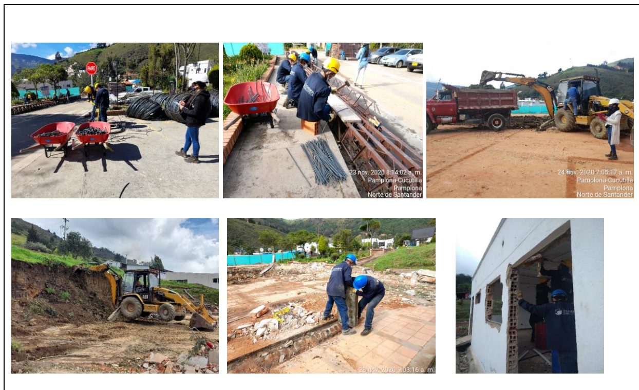
Figura 7 Actividades ejecutadas segundo corte
