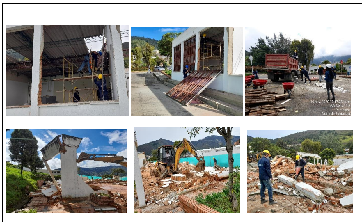
Figura 15 Desmante y demolición
