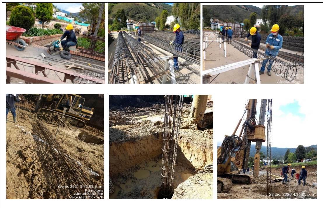
Figura 20 Acero de refuerzo para micropilotes
