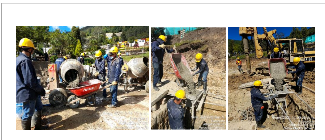
Figura 19 Concreto para micropilotes
