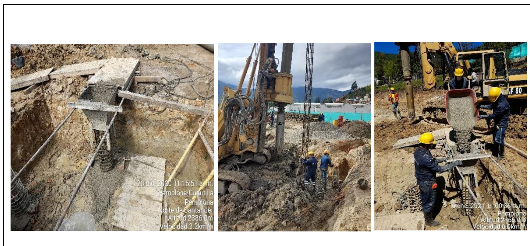
Figura 28 Procedimiento de fundida de micropilotes
