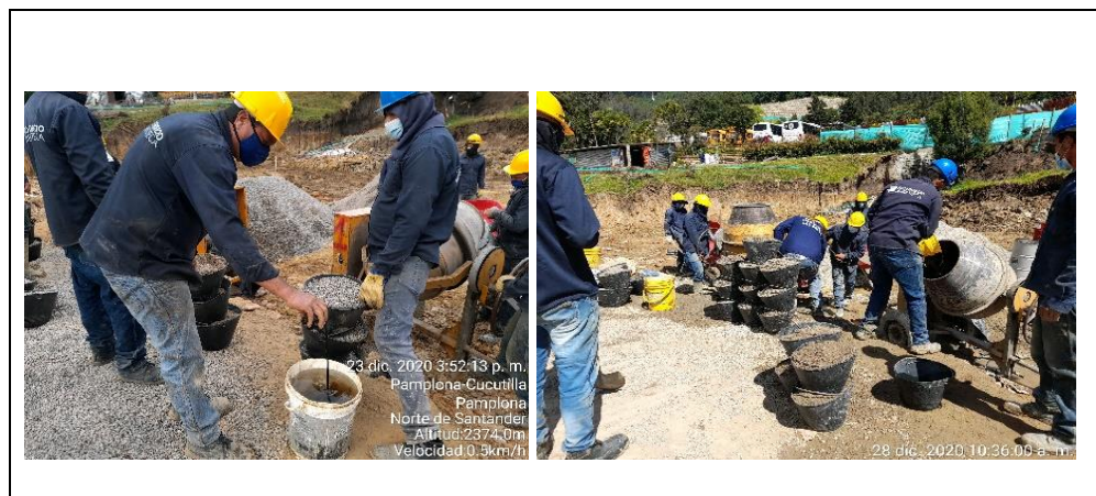
Figura 26 Preparación de la mezcla
