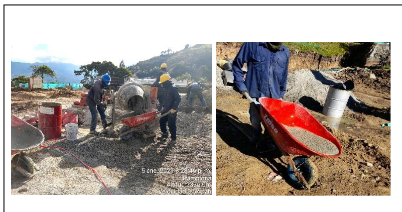
Figura 27 Concreto mezclado in situ
