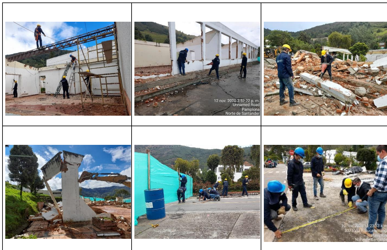
Figura 6 Actividades ejecutadas primer corte
