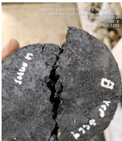
Figura 80, Fisura briqueta N4 en seco.
