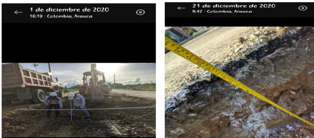
Al momento de realizar los respectivos chequeos y verificación de metrajes, espesores, niveles y profundidad de excavacion se comprobo que estos se realizaron de acuerdo a lo estipulado en los planos.
