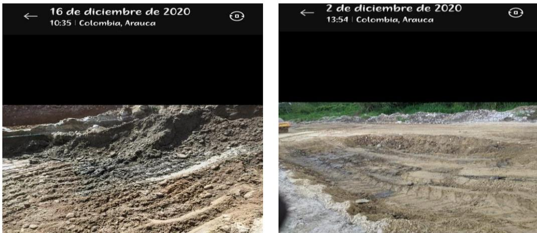
Se estuvo chequeando el ancho de la excavacion para asegurarnos de que correspondiera al ancho de la calzada estipulaod en los documentos el cual es de 6,60 mts.
