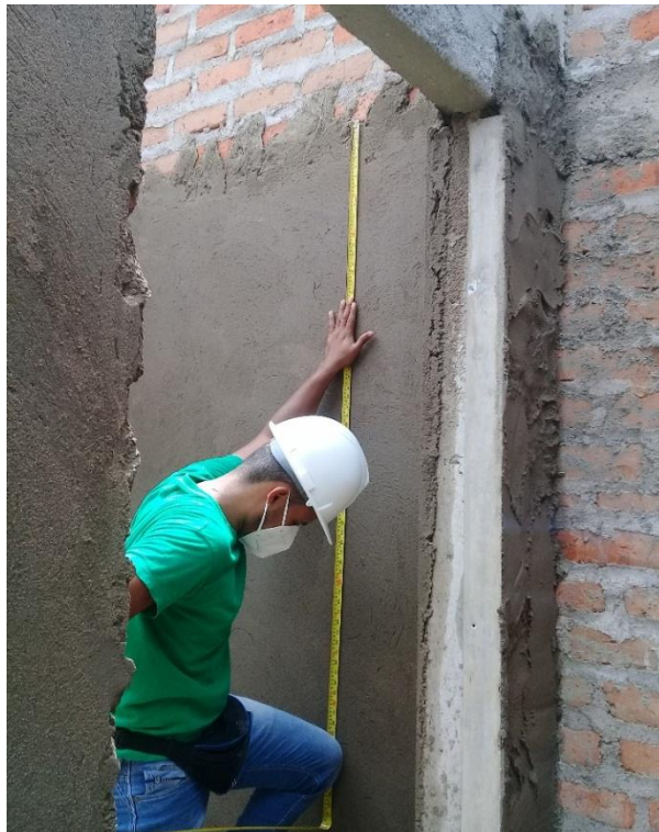
Mediciones de cantidades de obra
