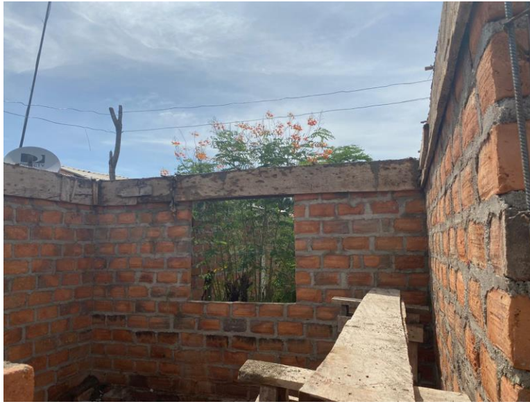
Formaleta Viga de Amarre.
