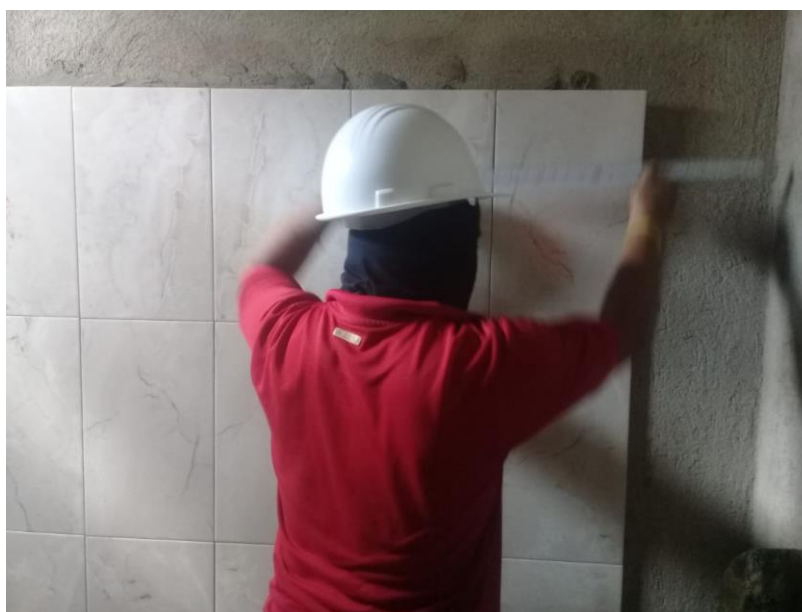
Enchapado de paredes de Baño.
