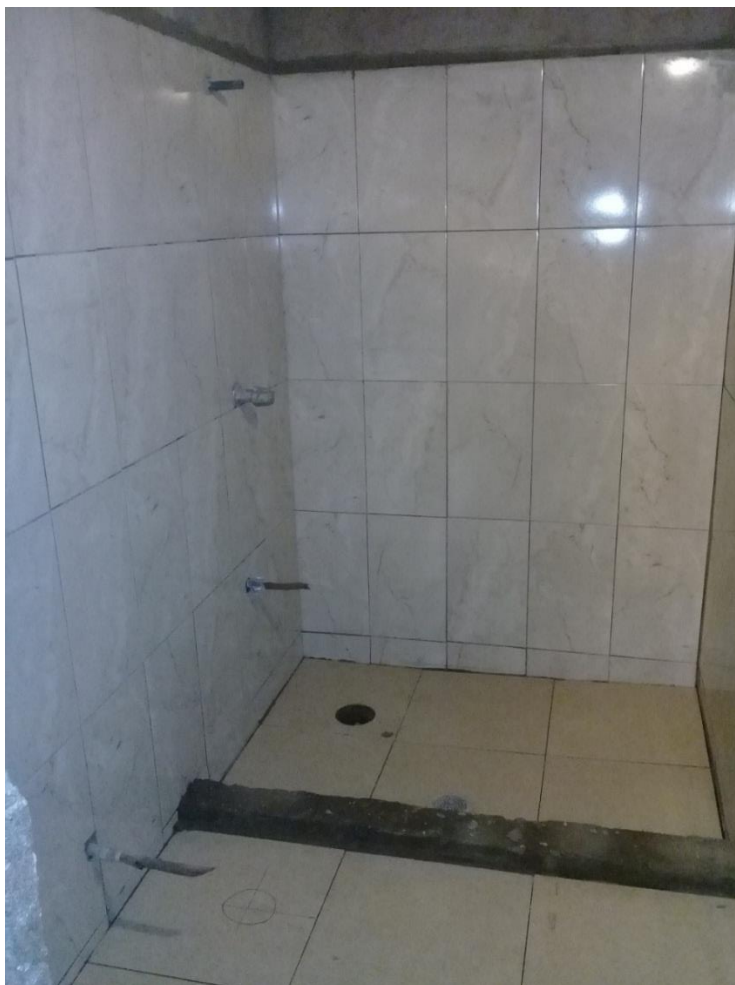
Enchapado de Piso de baño.
