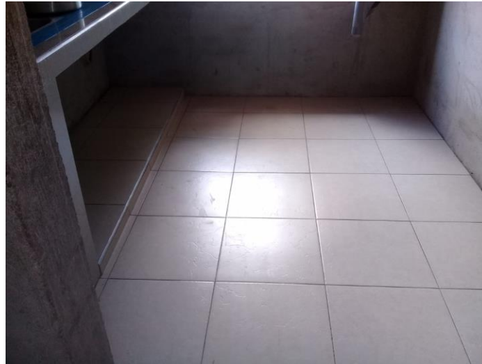
Enchapado de Piso de Cocina.
