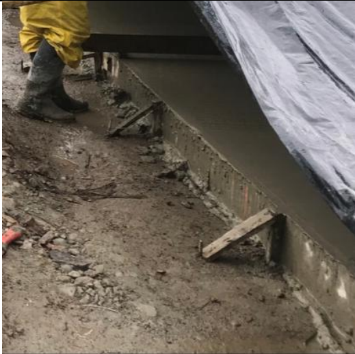
Figura 20. Varillas usadas como puntales
