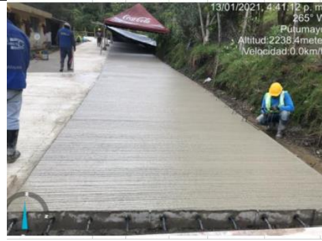
Figura 34. Acabado de placa mediante rayado
