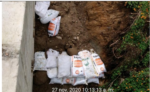
Figura 23 Relleno de material excavado
