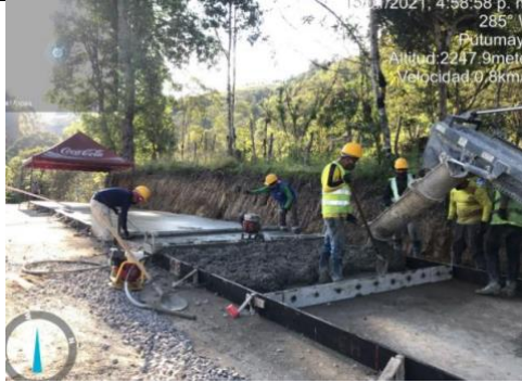
Figura 33. Vaciado del concreto a la placa
