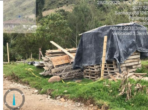
Figura 17. Orden y disposición de formaleta
