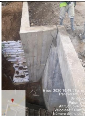
Figura 22. Aprovechamiento del material excavado
