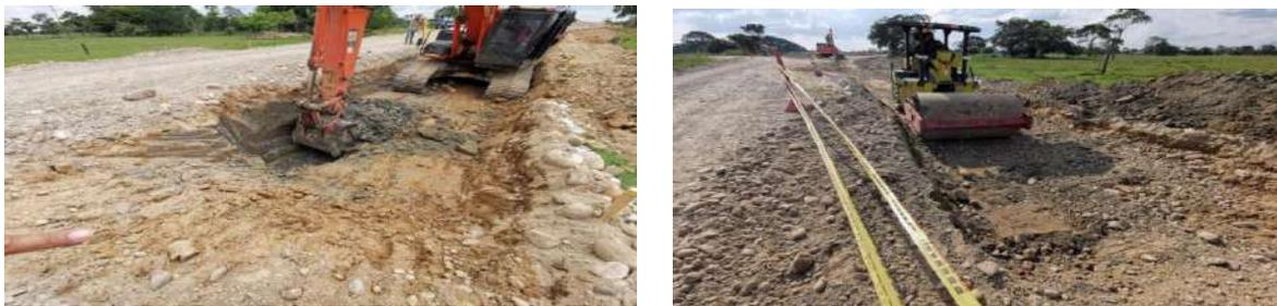
Ilustración 3 Estabilización de sub-rasante. Fuente (propia)
