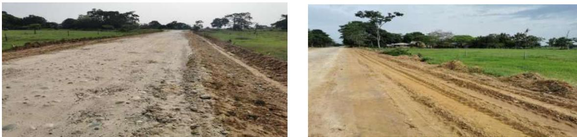
Ilustración 5 Perfilado y cuneteo. Fuente (propia)
