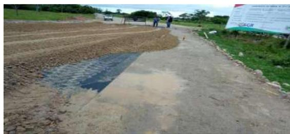
Ilustración 8 Subbase granular. Fuente (propia)
