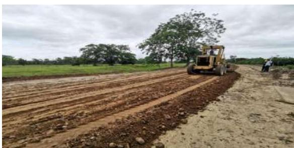
Ilustración 4 Escarificación conformación y compactación de la Subrasante. Fuente (propia)
