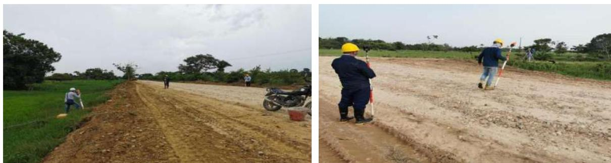
Ilustración 2 Localización y Replanteo Topográfico. Fuente (propia)
