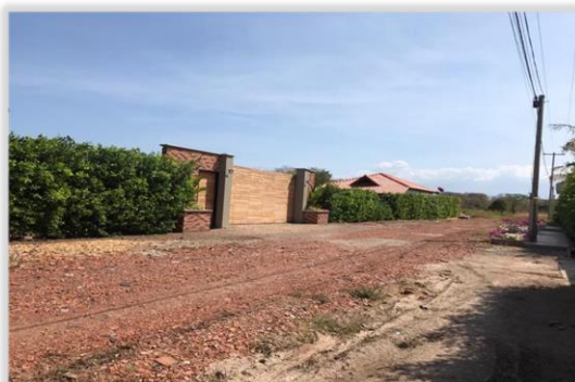
Ilustración 9: Cerramiento. Fuente: Propia.
