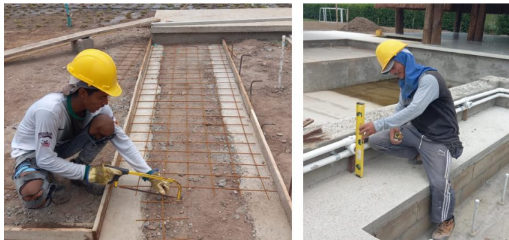
Ilustración 22: Uso de los EPP en obra. Fuente: Propia.
