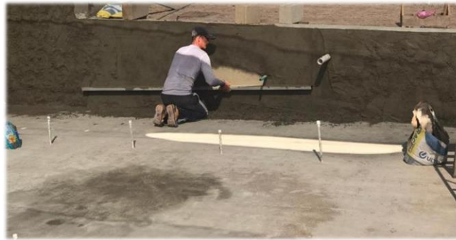
Ilustración 13: Pañete de paredes. Fuente: Propia.
