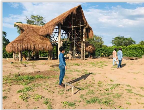
Ilustración 8: Localización y replanteo. Fuente: Propia.
