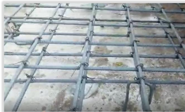
Ilustración 11: Armado de acero. Fuente: Propia.
