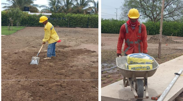
Ilustración 21: Uso de los EPP en obra. Fuente: Propia.
