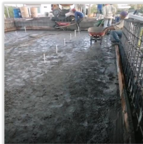
Ilustración 12: Vaciado de concreto. Fuente: Propia.
