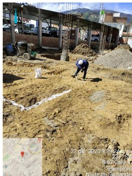
Ilustración 21: *Excavación mecánica para cimientos*
