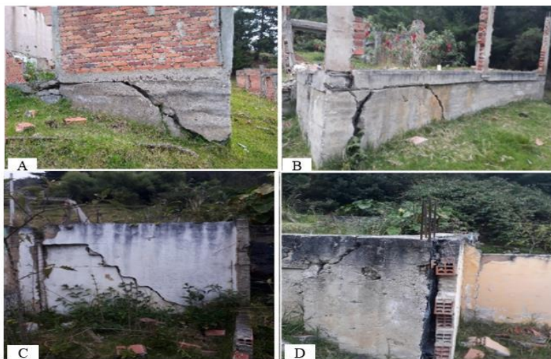
Figura 2: Fallas estructurales:
