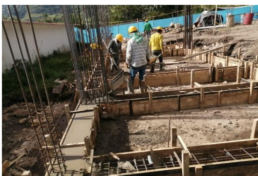
Ilustración 14. Vaciado de concreto, Descargue de material
