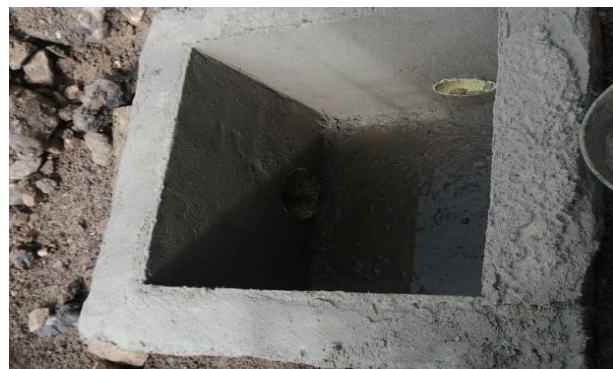
Ilustración 21. Caja de inspección y figurado de acero para gradería
