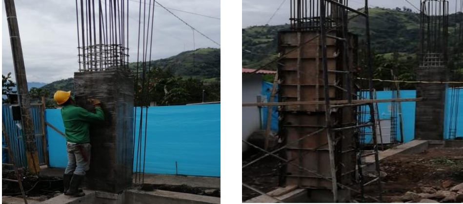
Ilustración 16. Desencofrado y curado del concreto
