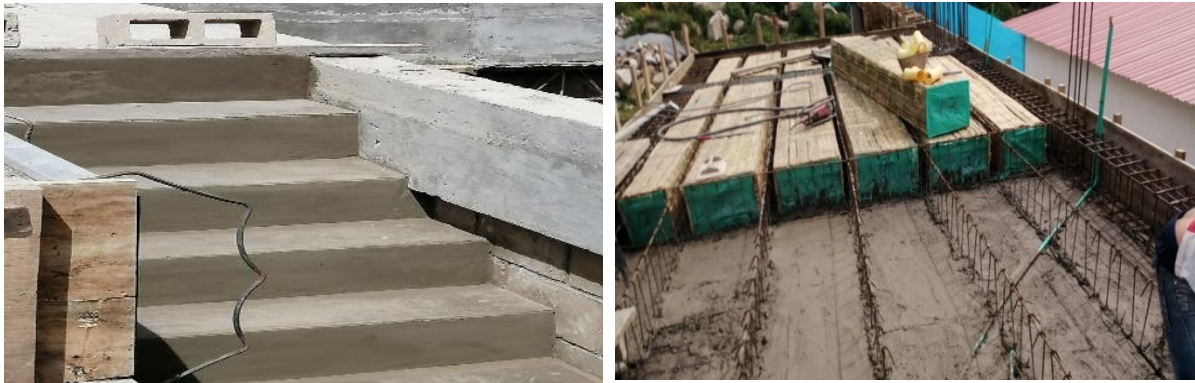
Ilustración 23. Instalación de placa aligerada
