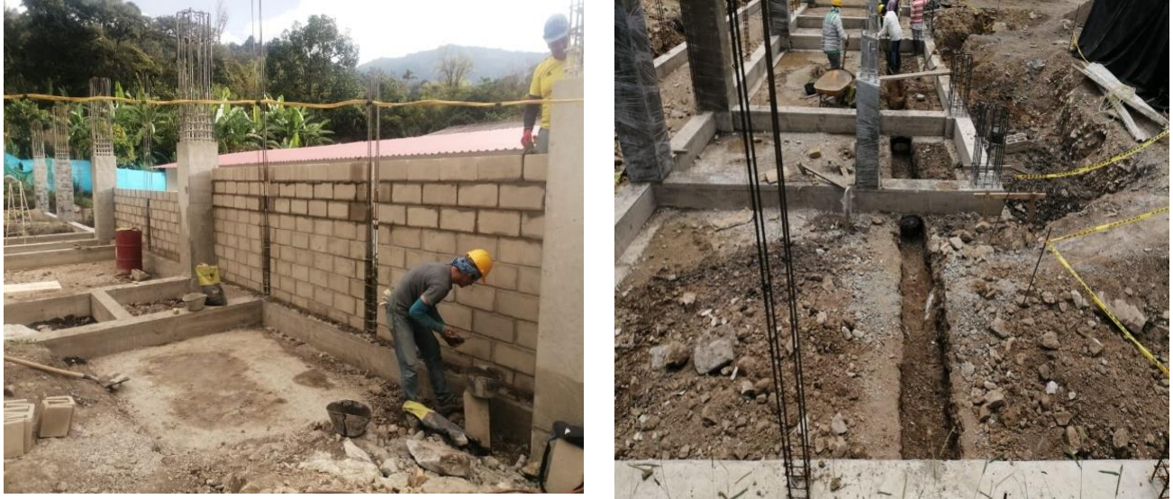
Ilustración 19. Mampostería y excavación de para hidrosanitarios
