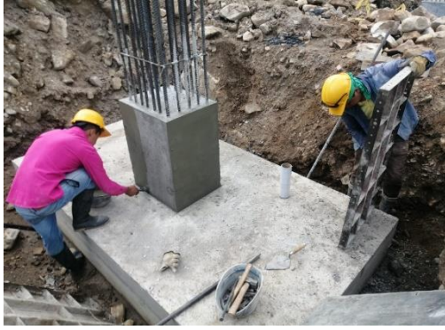
Ilustración 7. Desencofrado y Compactación
