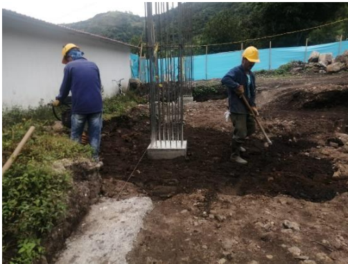
Ilustración 8. Instalación de Relleno y Excavación para vigas
