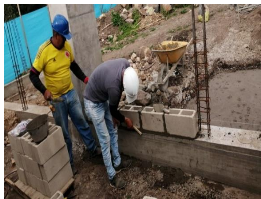
Ilustración 17. Mampostería en bloque
