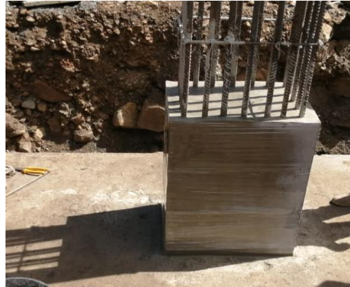
Ilustración 4. Figurado de acero y Fraguado del concreto
