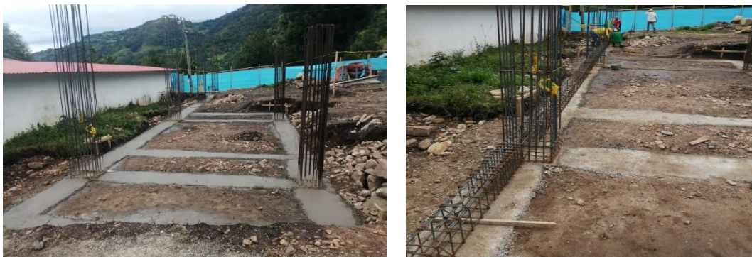
Ilustración 10. Instalación de solado y Armado de vigas
