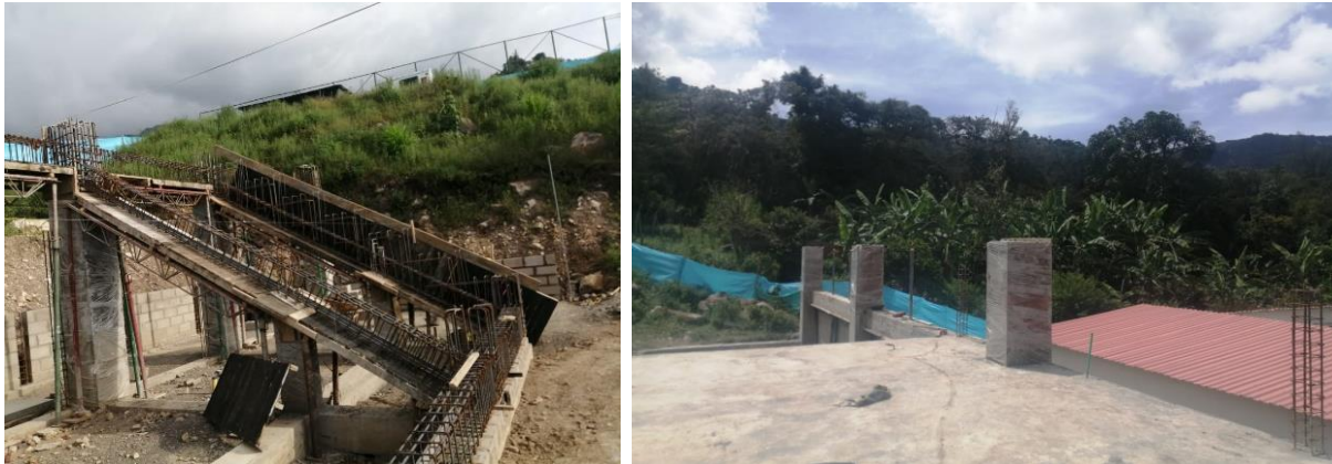
Ilustración 24. Figurado de acero para gradería
