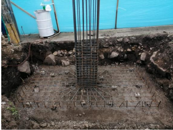
Ilustración 4. Figurado de acero y Fraguado del concreto
