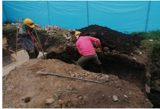
Ilustración 8. Instalación de Relleno y Excavación para vigas
