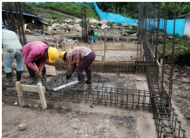
Ilustración 13. Figurado de acero para vigas
