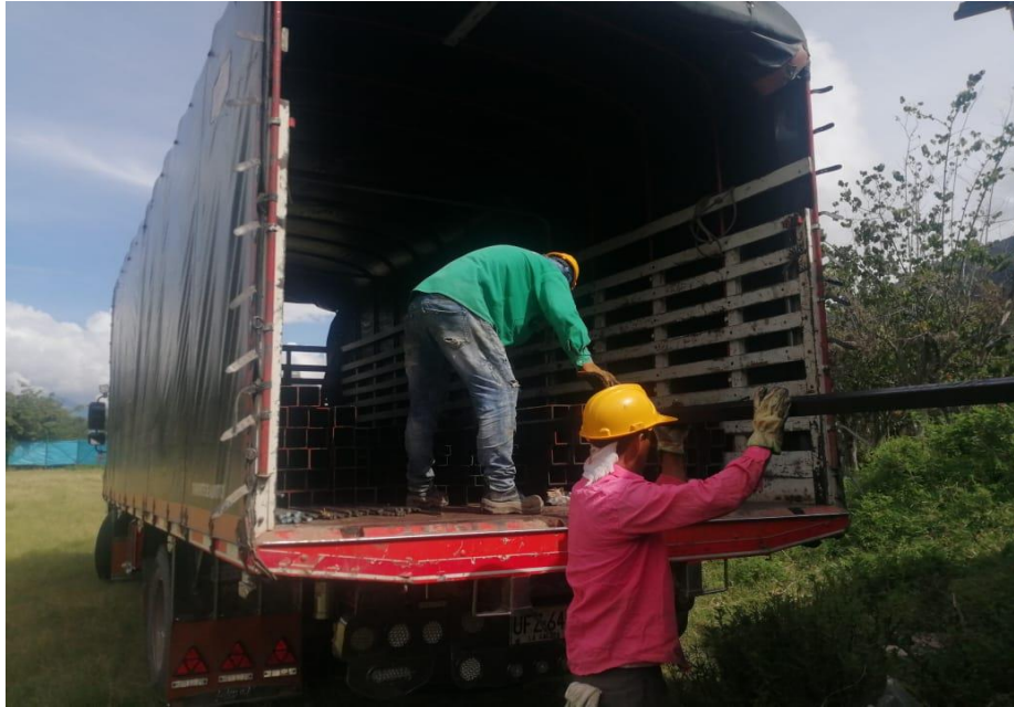
Ilustración 31. Control de la llegada de material
