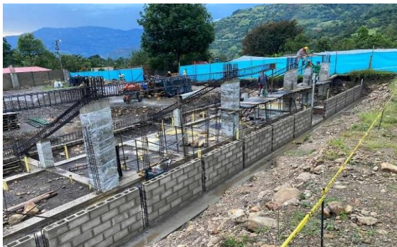
Ilustración 21. Caja de inspección y figurado de acero para gradería
