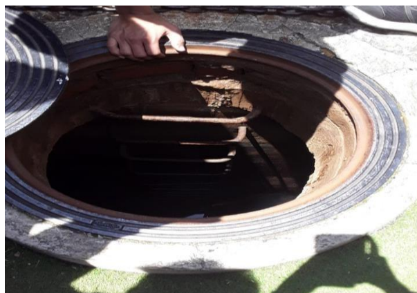
Fotografía 6. Entrada al tanque de almacenamiento
