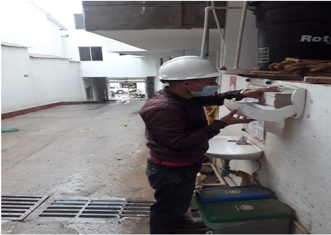
Figura 7: Adecuación de la Zona de Desinfección.
