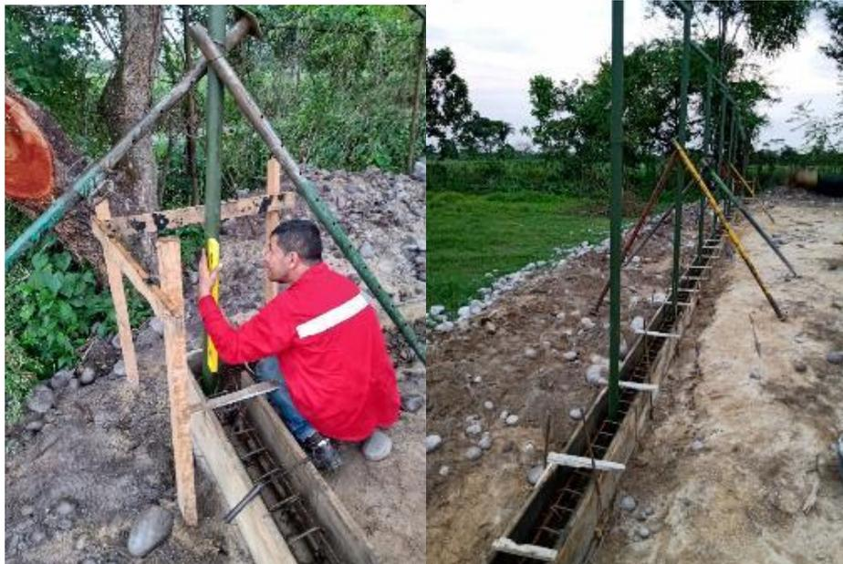
Ilustración 25 Colocación Nivelación y Plomada de la Tubería Fuente: Propia
