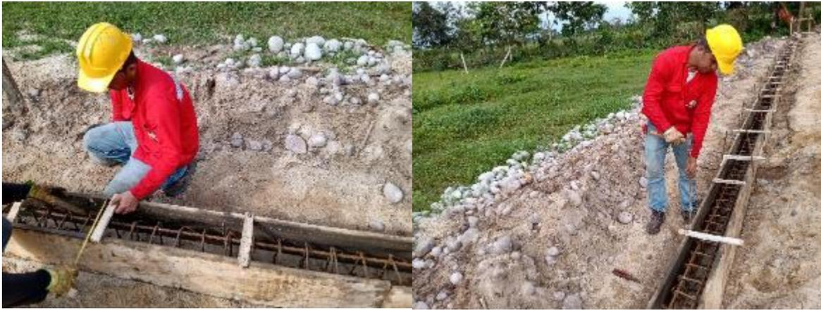
Ilustración 24 Encofrado para Viga Fuente Propia
