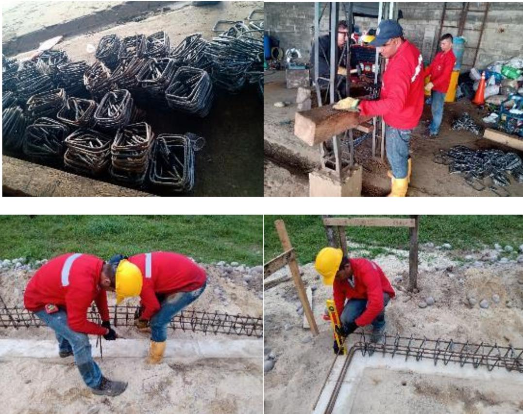
Ilustración 23 Armado y Figurado de Acero Fuente: Propia
