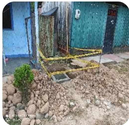
**Ilustración 11 Caja de Inspección 70x70x70 cms**
