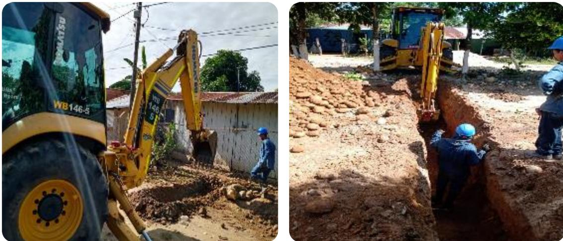
**Ilustración 6 Excavación Mecánica en Conglomerado**
