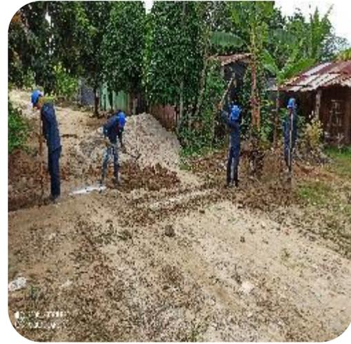
**Ilustración 5 Excavación Manual en Conglomerado**
