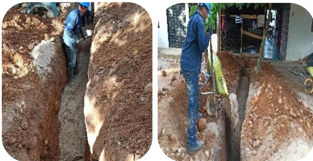
**Ilustración 8 Material Fino Para Cimentacion de Tubería 6”**
