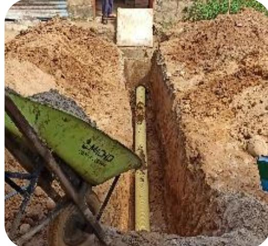
**Ilustración 9 Suministro e Instalación de Tubería pvc 6''**
