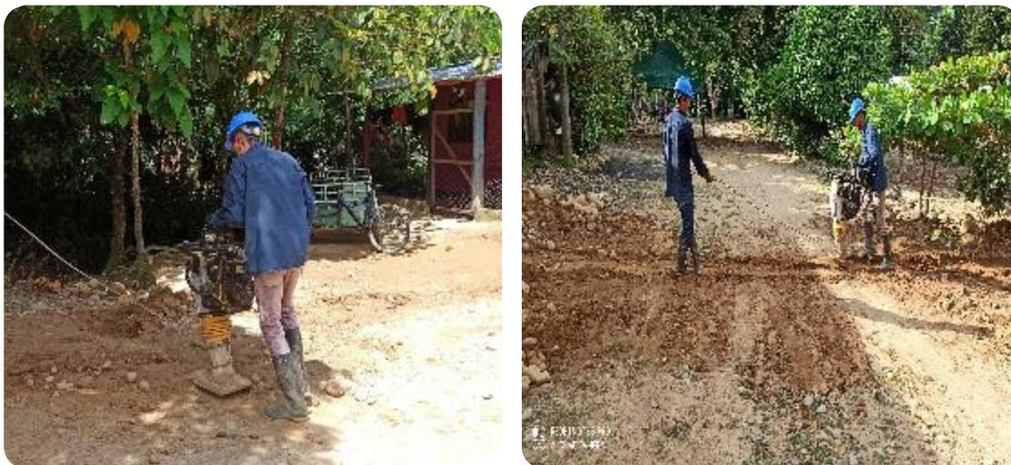
**Ilustración 7 Relleno Compactado con Material Seleccionado de la Misma Excavación**
