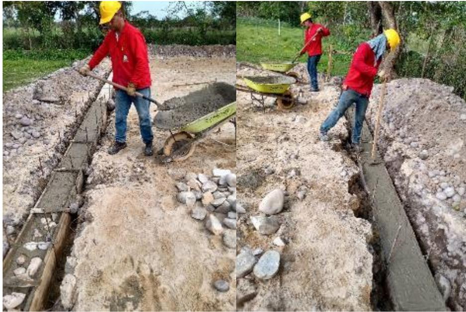
Ilustración 22 Fundición del Ciclópeo Fuente: Propia
