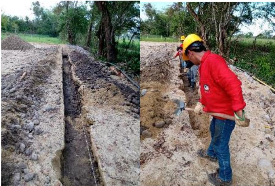
Ilustración 20 Excavación Manual Ciclópeo fuente: Propia
