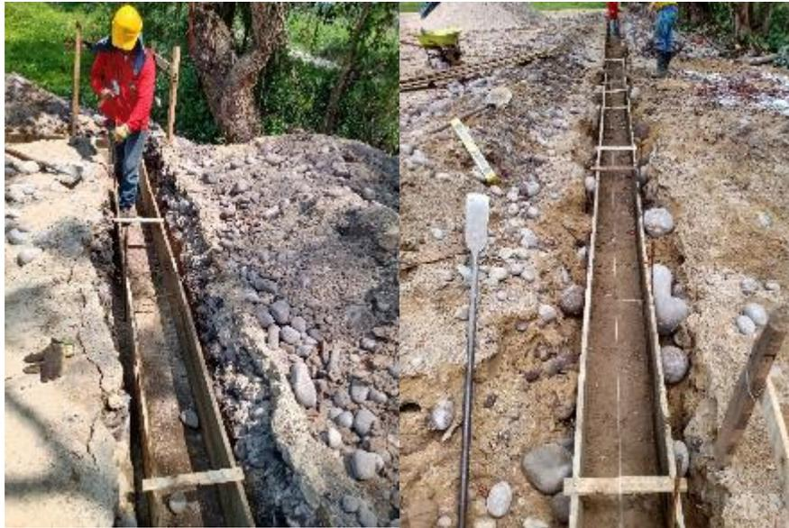
Ilustración 21 Encofrado Ciclópeo fuente: Propia
