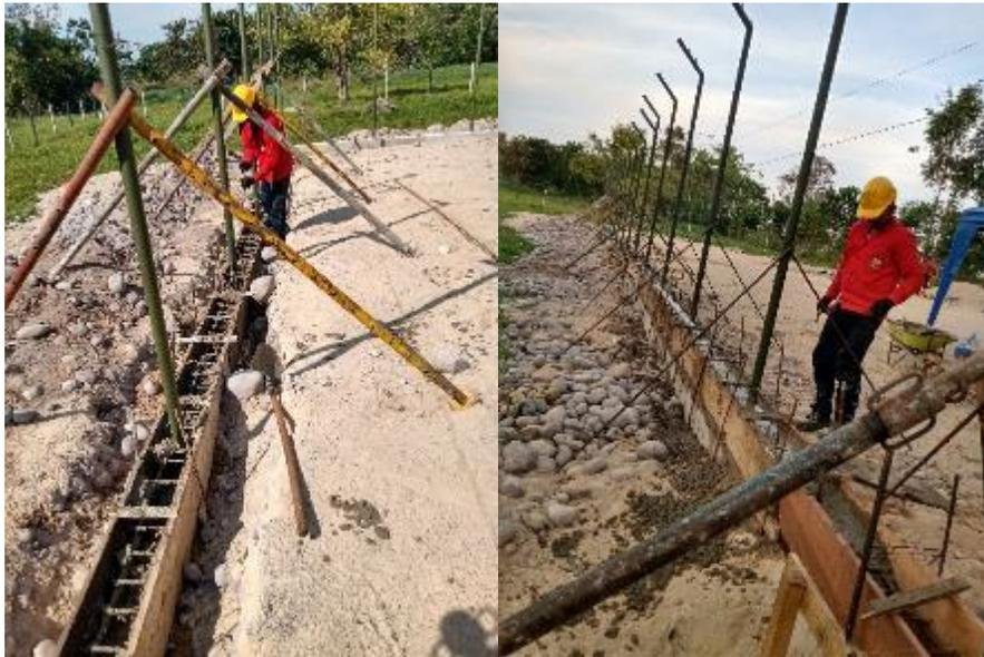
Ilustración 26 Fundición para Viga Fuente: Propia
