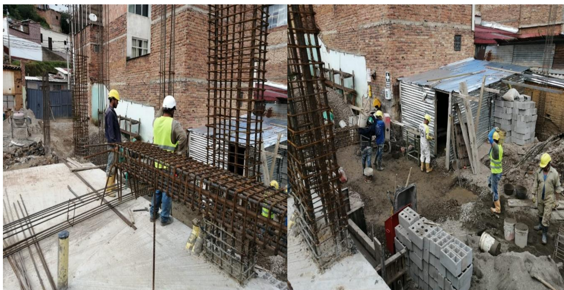
Figura 31. Detalle de construcción de columnas.
