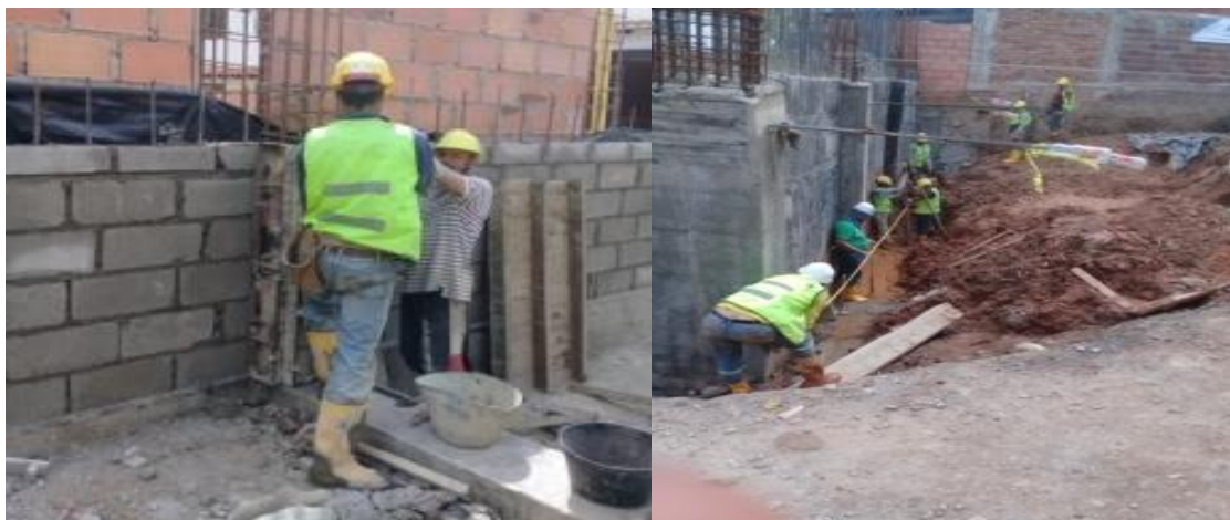
Figura 26. Detalle de muros en bloque y reforzado
