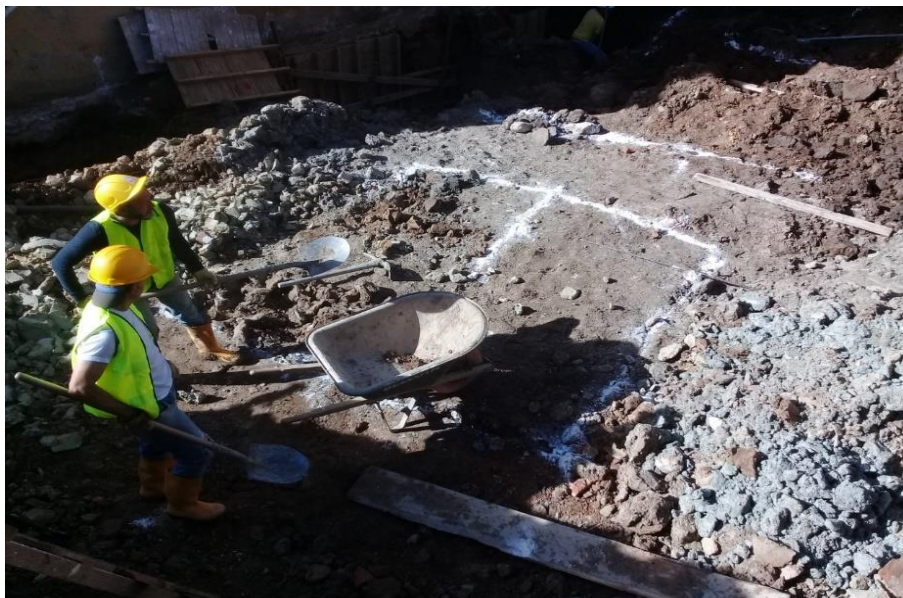
Figura 9. Inicio del proceso de excavación
