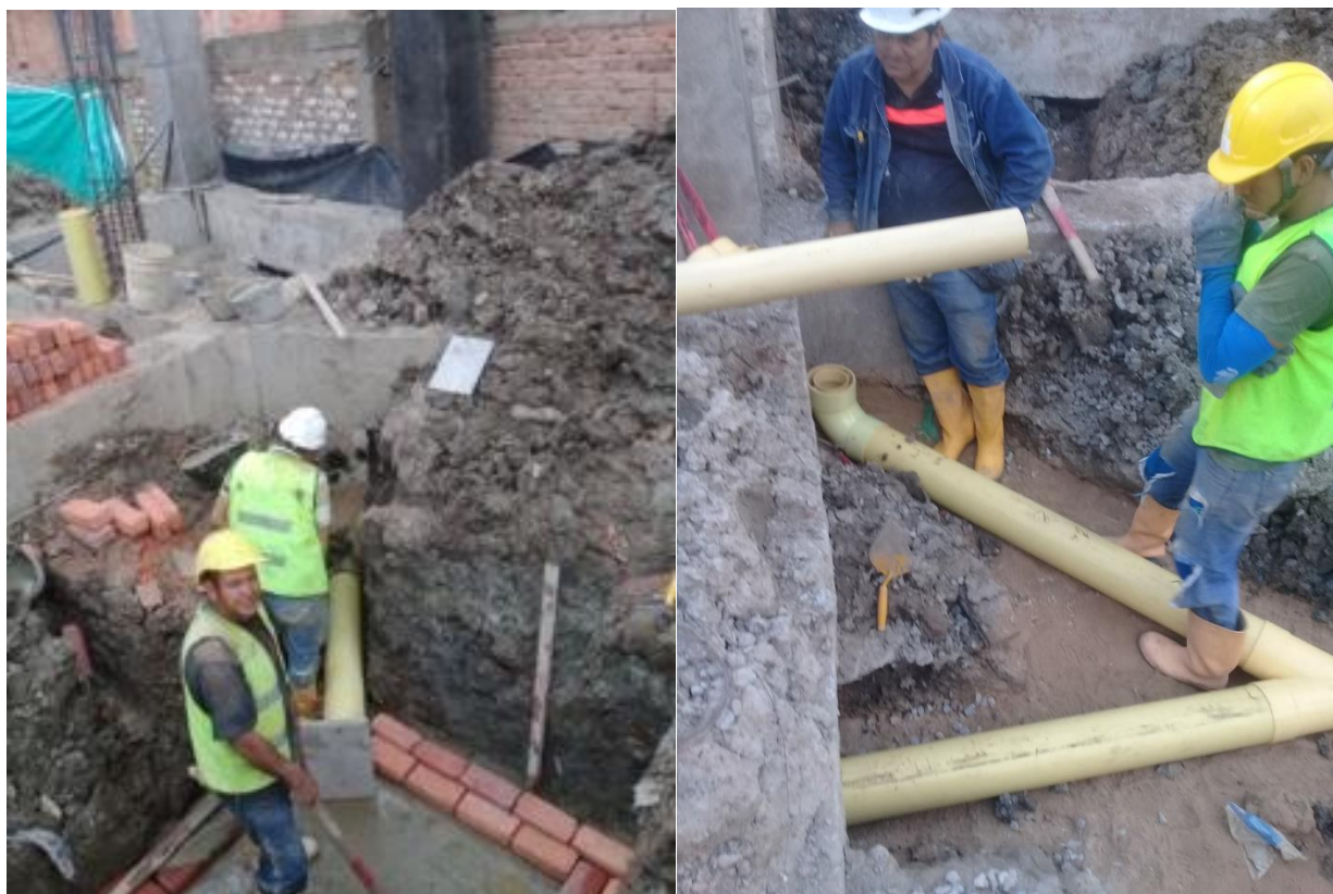
Figura 34. Instalación de redes sanitarias
