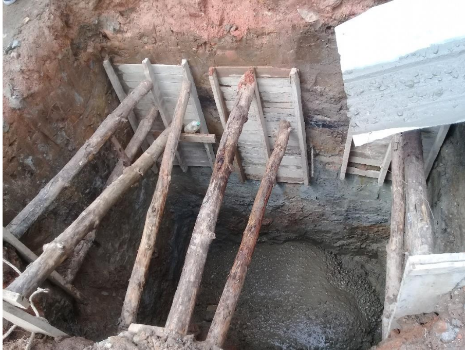
Figura 37. Uso de entibados en las excavaciones
