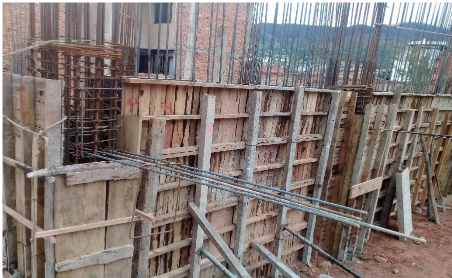
Figura 39. Instalación de formaleta de madera
