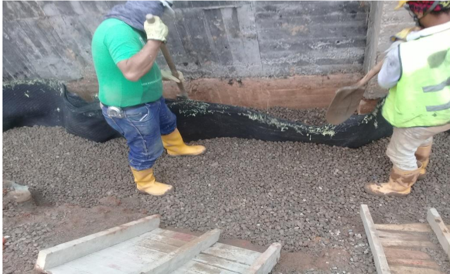
Figura 38. Instalación de filtros
