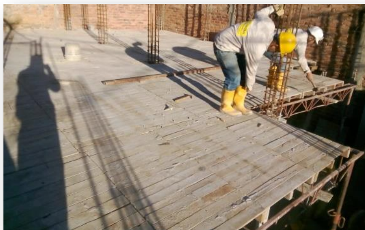
Ilustración 5. Encofrado losa de entrepiso N.E +3m
