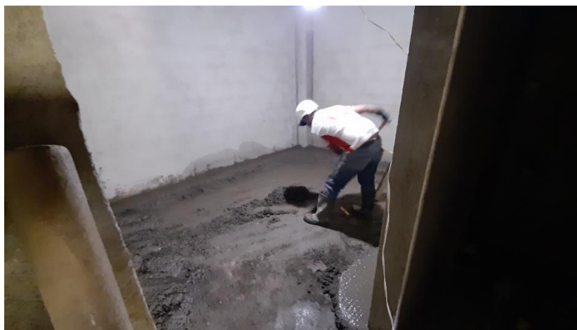
Ilustración 39. Esparcimiento de mortero de antepiso
