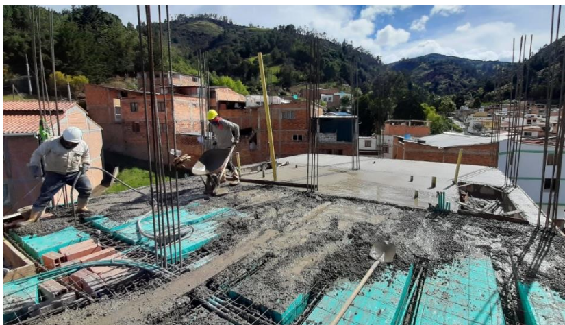
Ilustración 40. Vaciado de concreto en placa de entrepiso
