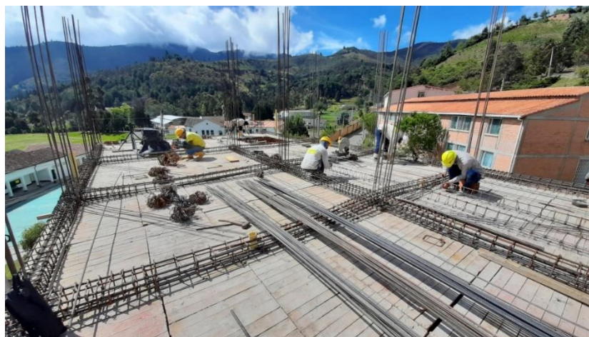
Ilustración 35. Colocación y Amarre de vigas y viguetas
