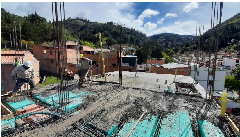
Ilustración 37. vibrado mecánico del concreto
