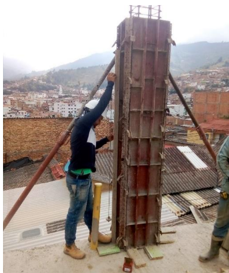
Ilustración 28. Verificación de plomos en el encofrado de la columna
