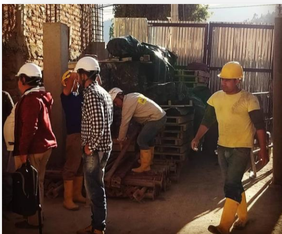
Ilustración 3. Estado inicial obra Getsemaní
