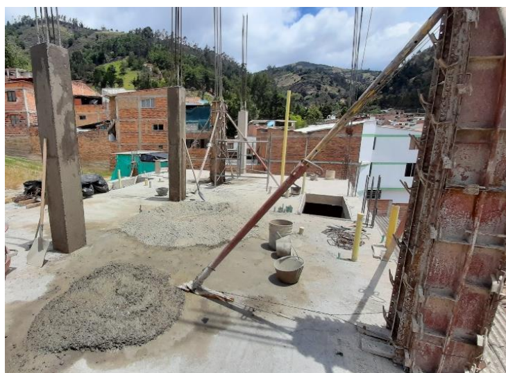
Ilustración 29. Fundida de columnas con concreto mezclado de forma manual
