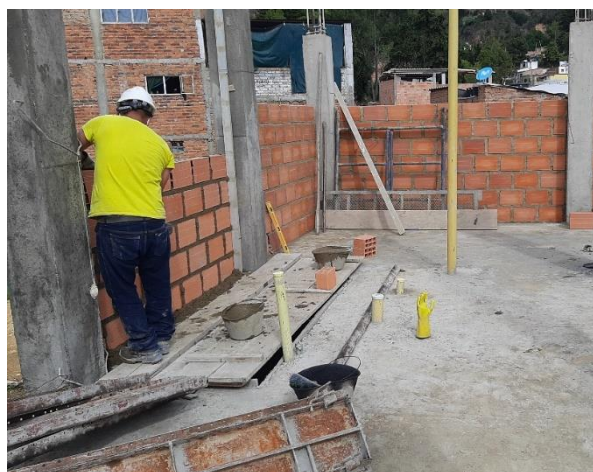
Ilustración 25. Mampostería en bloque N.º 5
