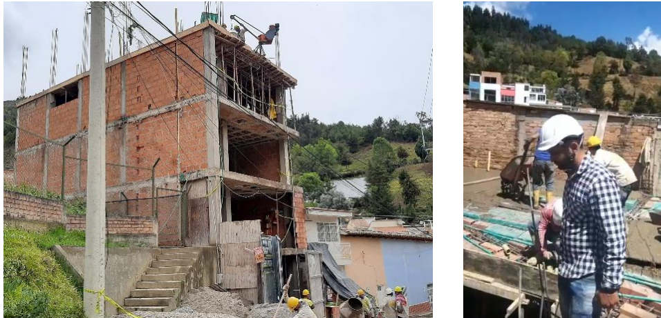
Ilustración 36. Vaciado de concreto
