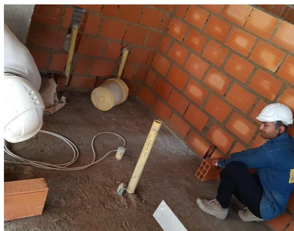
Ilustración 26. Replanteo de muros internos
