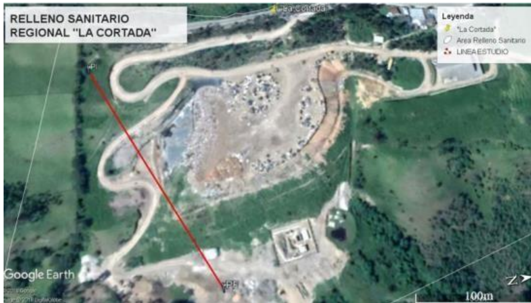
Figura 4-18 Localización de la línea de estudio relleno sanitario La Cortada
