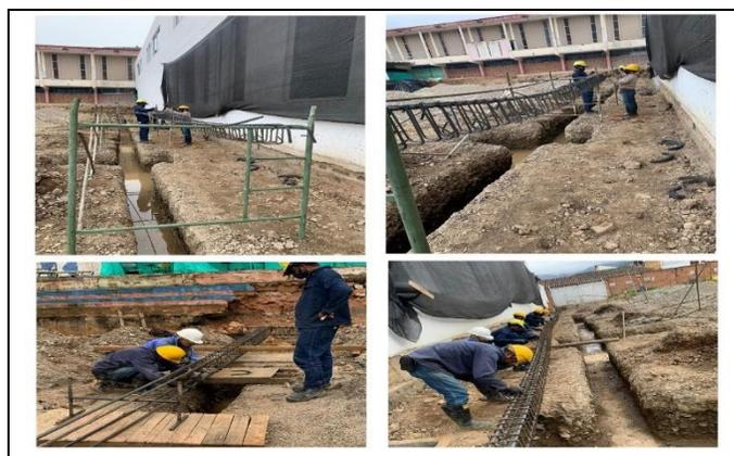
*Ilustración 31. armado de aceros cimentación*
