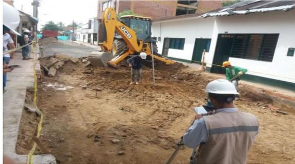
Ilustración 3 Demolición pavimento flexible con máquina.
