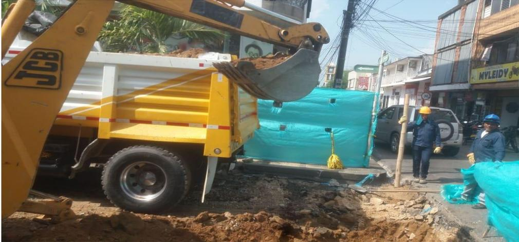
Ilustración 4 Excavación mecánica cargue y disposición final de material común.
