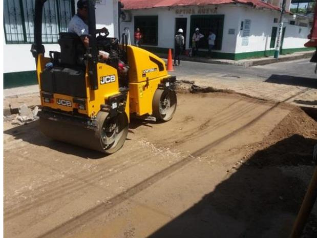
Ilustración 10 Base granular bg-1 con topografía
