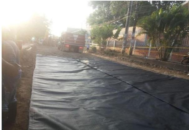
Ilustración 8 Geotextil nt2500 instalado.
