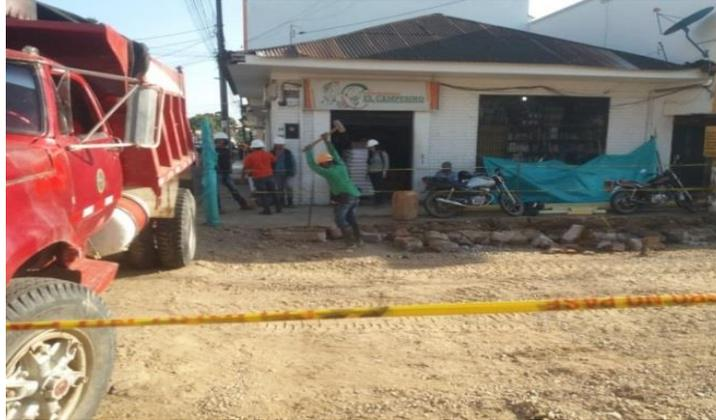
Ilustración 6 Carga y retiro de escombros manualmente
