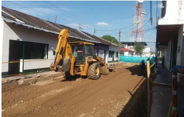
Ilustración 9 Sub-base granular CBR 30% con topografía.
