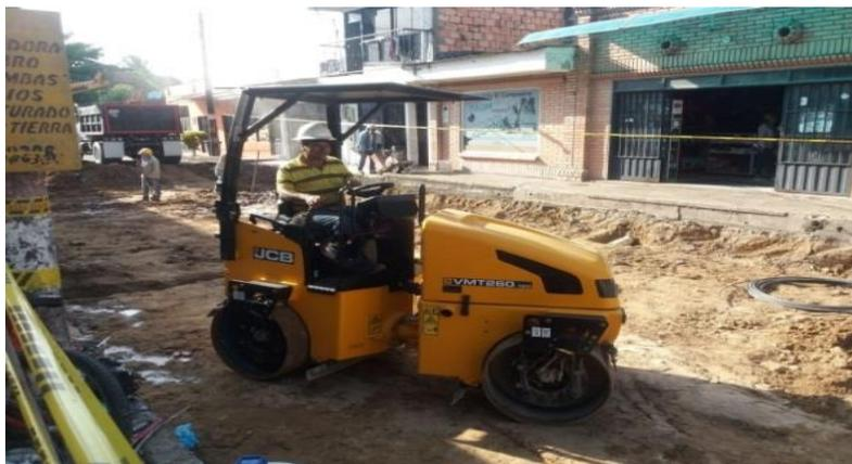
Ilustración 7 Conformación y compactación de la Subrasante.
