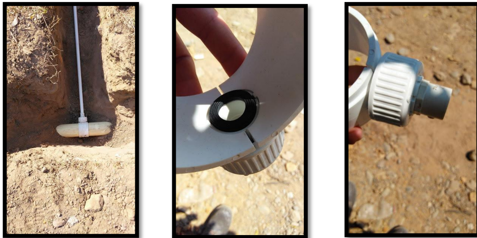
Ilustración 5 Cambio de posición de collarines.
