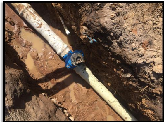
Ilustración 10. Instalación de válvulas de control.
