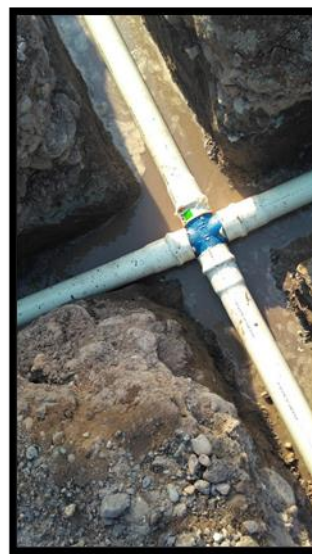
Ilustración 7. Instalación de cruz.
