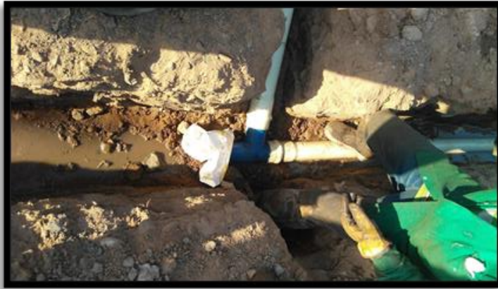
Ilustración 8. Instalación de tes.
