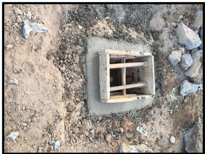
Ilustración 11. Cajillas para válvulas de control.
