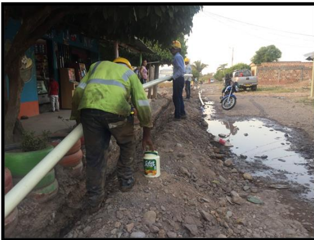
Ilustración 13. instalación de tubería.
