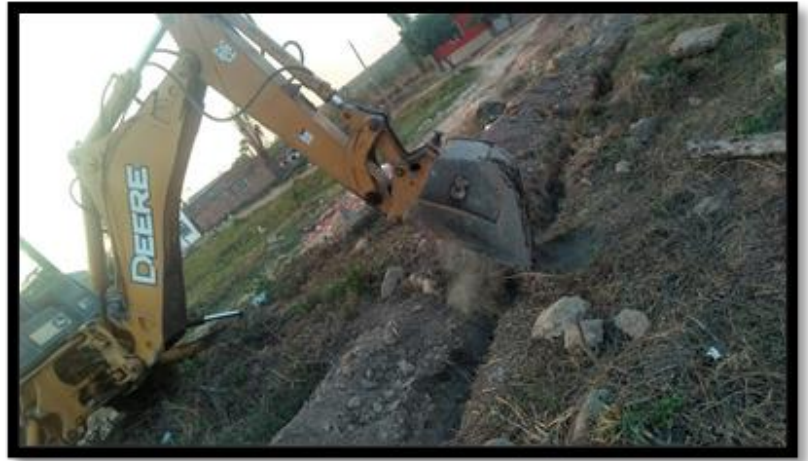
Ilustración 16. Remoción de material rocoso.
