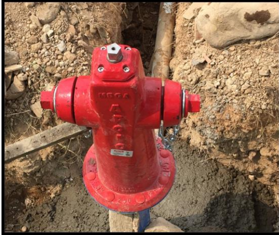
Ilustración 12. Instalación de hidrantes.
