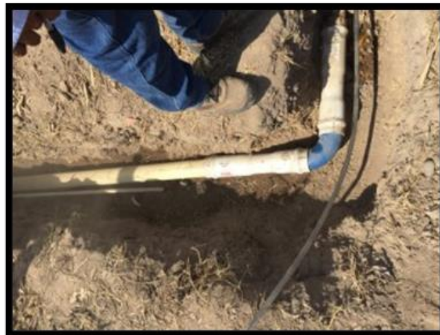
Ilustración 9. Instalación de codos.
