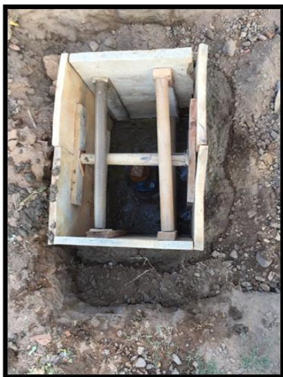
Ilustración 11. Cajillas para válvulas de control.
