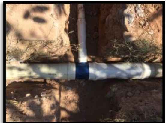
Ilustración 8. Instalación de tes.
