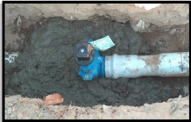
Ilustración 10. Instalación de válvulas de control.
