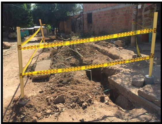
Ilustración 16. Remoción de material rocoso.
