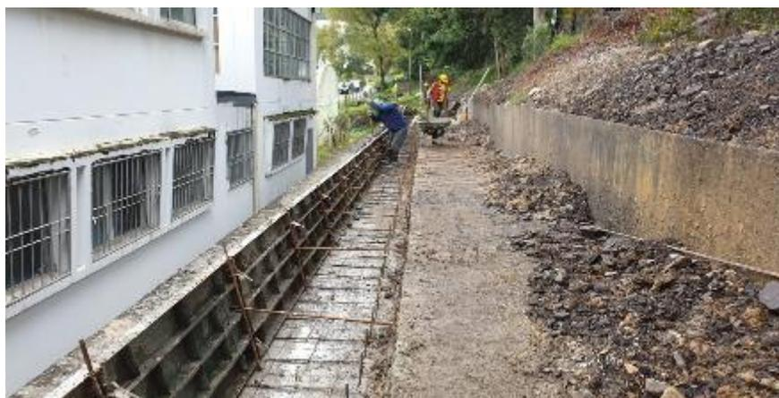
*Nota.* Se verificó la configuración del acero para la cuneta, de acuerdo al diseño se midió el correcto espaciamiento entre barras No.6 – 3/4 pulg.
