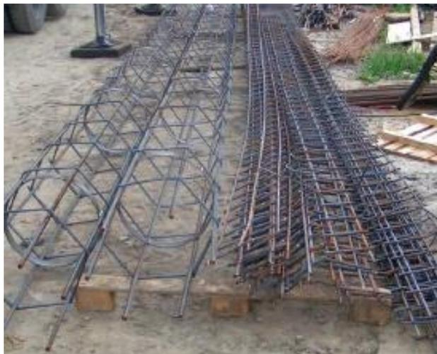
*Nota.* La figura presenta el armado del acero para los micropilotes, sobre los cuales se verificó la cantidad de varillas por pilotes y el distanciamiento entre las espirales, de acuerdo al diseño estructural.
