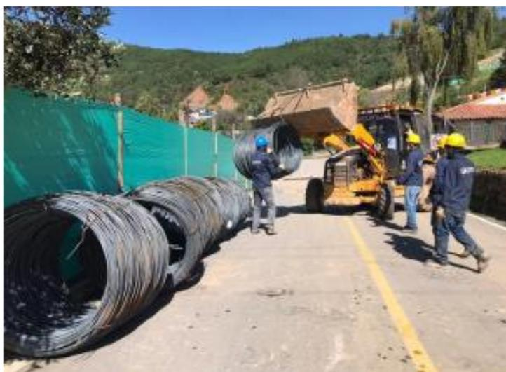
*Nota.* La Figura 51 muestra el acero recibido, luego se procedió a su correcta disposición y armado para pilotes, cabezales y viga de amarre de cimentación
