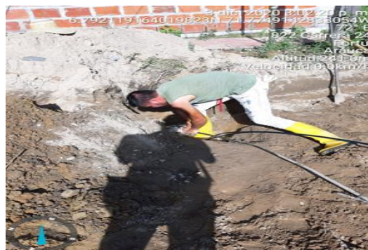
Ilustración 32: Reparación Acometida Hidráulica. Sarmiento Gonzalo (2020)
