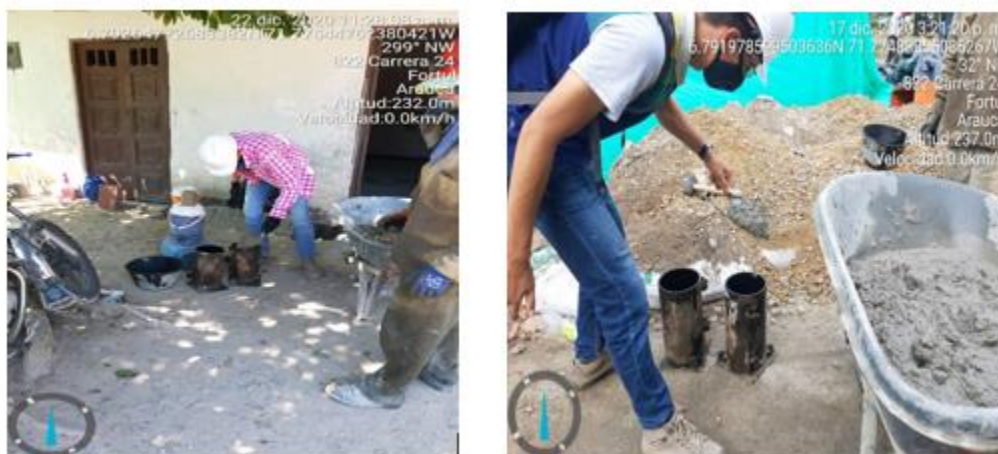
Ilustración 62: Toma de muestras para ensayo de resistencia de concreto. Sarmiento Gonzalo (2020)
