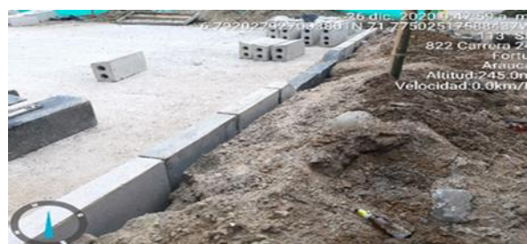
Ilustración 24: Suministro e instalación de sardinel tipo IDU A-10, A-85, A-100. Sarmiento Gonzalo (2020)
