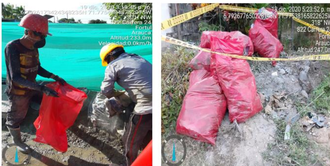
Ilustración 47: Limpieza sitio de Trabajo. Sarmiento Gonzalo (2020)
