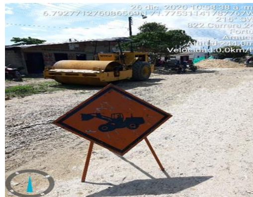
Ilustración 42: Señalización (maquinaria en la vía). Sarmiento Gonzalo (2020)
