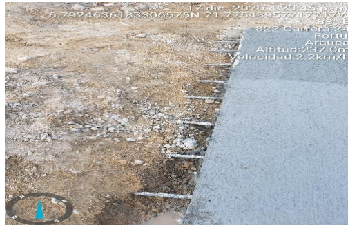
Ilustración 19: Acero de refuerzo fy=6000 PSI. Sarmiento Gonzalo (2020)
