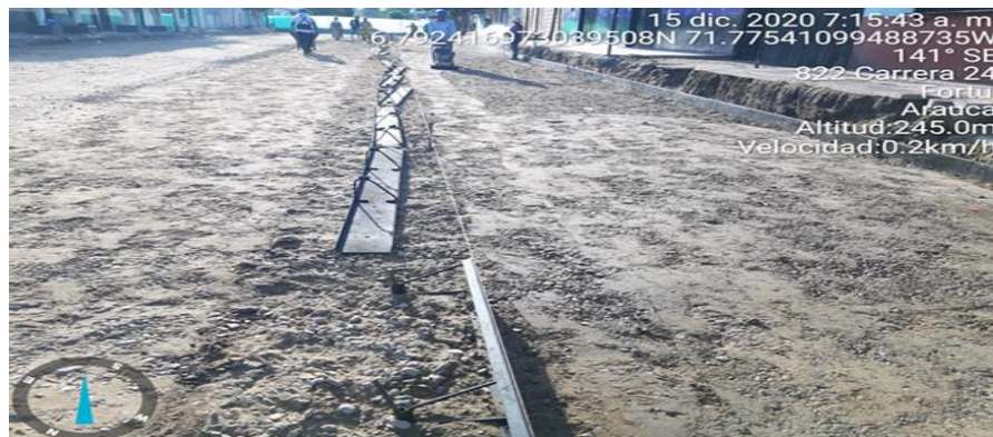
Ilustración 55: Nivelación y limpieza de la superficie de trabajo. Sarmiento Gonzalo (2020)
