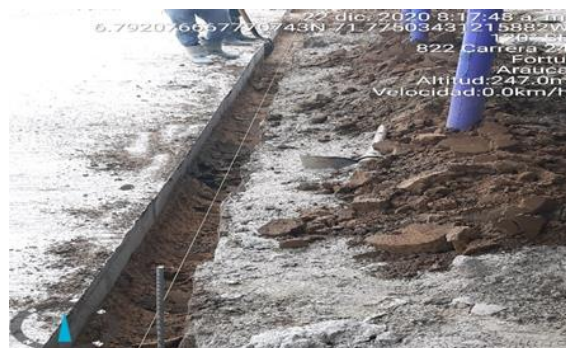
Ilustración 23: Excavación Manual para instalación de sardineles. Sarmiento Gonzalo (2020)
