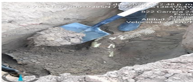
Ilustración 28: Relleno compactado con material seleccionado. Sarmiento Gonzalo (2020)
