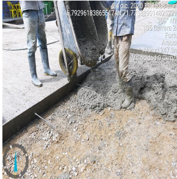
Ilustración 59: Vaciado de Concreto. Sarmiento Gonzalo (2020)
