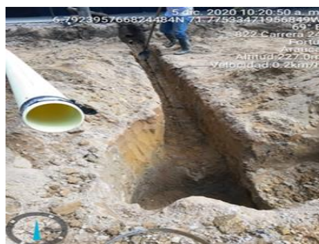
Ilustración 29: Suministro e instalación de tubería de 6". Sarmiento Gonzalo (2020)
