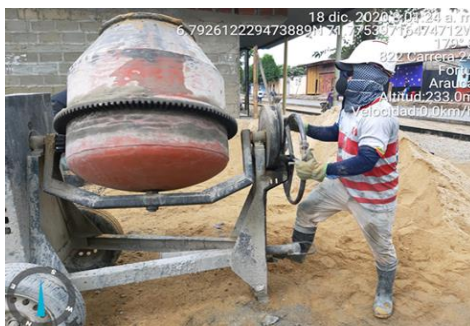
Ilustración 57: Mezclado de materiales. Sarmiento Gonzalo (2020)
