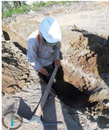
Ilustración 27: Excavación Manual en material común. Sarmiento Gonzalo (2020)
