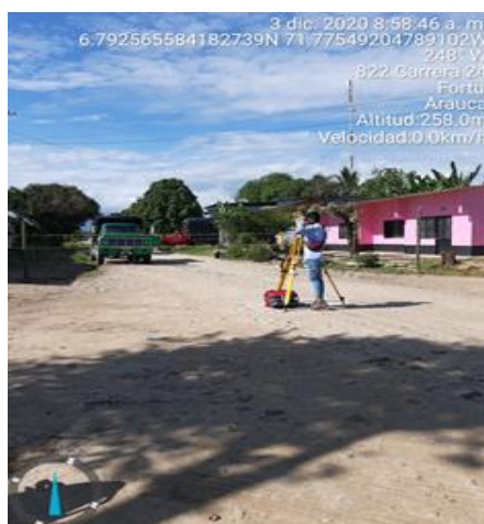
Ilustración 11: Localización y replanteo topográfico vial. Sarmiento Gonzalo (2020)
