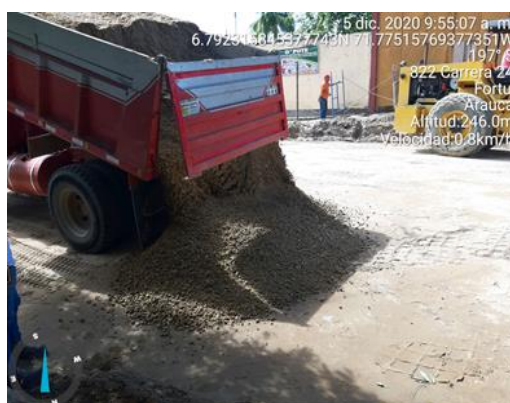
Ilustración 15: Suministro de base granular. Sarmiento Gonzalo (2020)
