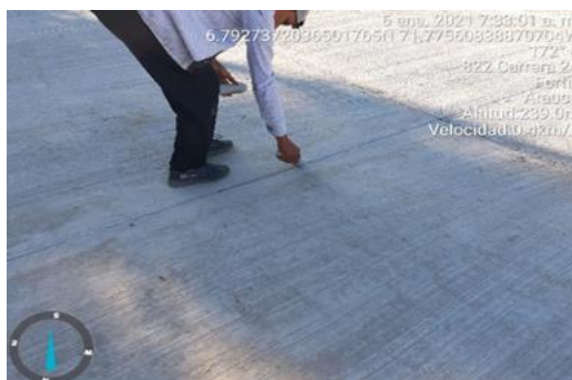
Ilustración 21: Sellado de juntas de dilatación. Sarmiento Gonzalo (2021)
