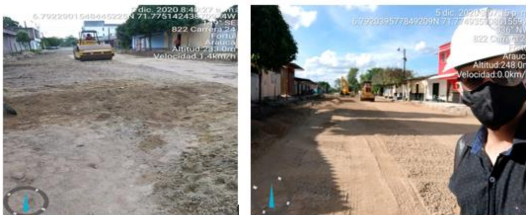
Ilustración 14: Conformación de la subrasante. Sarmiento Gonzalo (2020)
