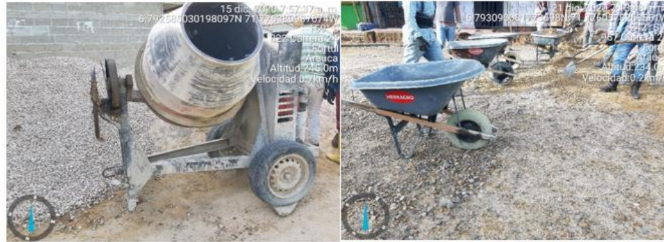
Ilustración 54: Equipo de mezclado y transporte de concreto. Sarmiento Gonzalo (2020)
