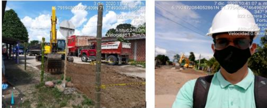
Ilustración 12: Excavación Mecánica. Sarmiento Gonzalo (2020)
