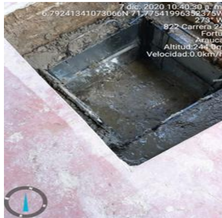
Ilustración 31: Caja concreto 3000 PSI. Sarmiento Gonzalo (2020)
