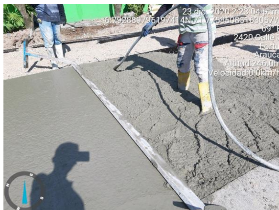
Ilustración 60: Vibrado de concreto. Sarmiento Gonzalo (2020)
