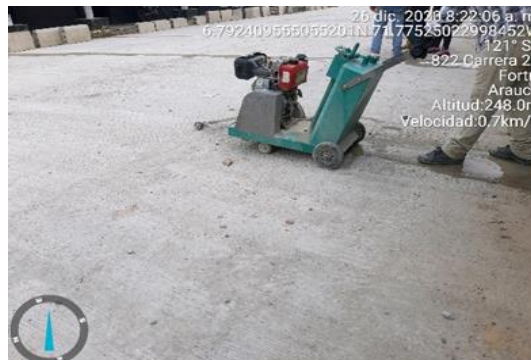
Ilustración 20: Corte de Juntas de Dilatación. Sarmiento Gonzalo (2020)
