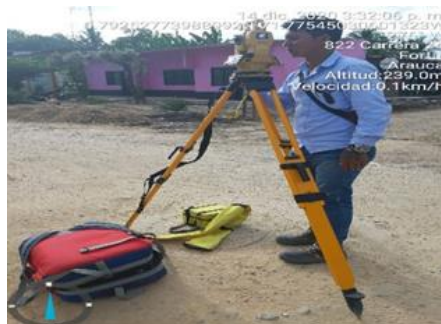
Ilustración 22: Localización y replanteo Topográfico de Sardineles. Sarmiento Gonzalo (2020)
