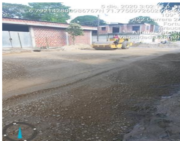
Ilustración 17: Compactación Base Granular. Sarmiento Gonzalo (2020)
