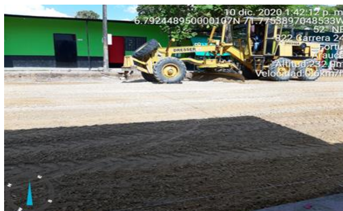
Ilustración 16: Extendida de Base Granular. Sarmiento Gonzalo (2020)
