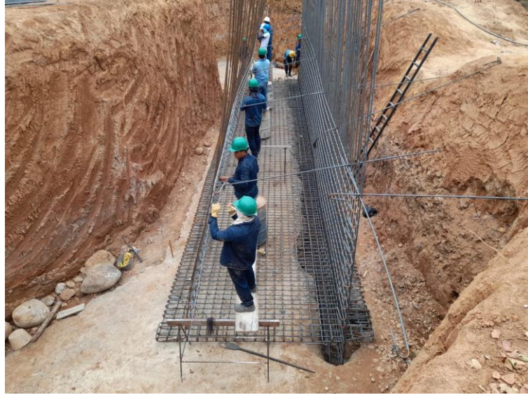
Ilustración 80. ÍTEM: 13.2 Acero de Refuerzo Grado 60
