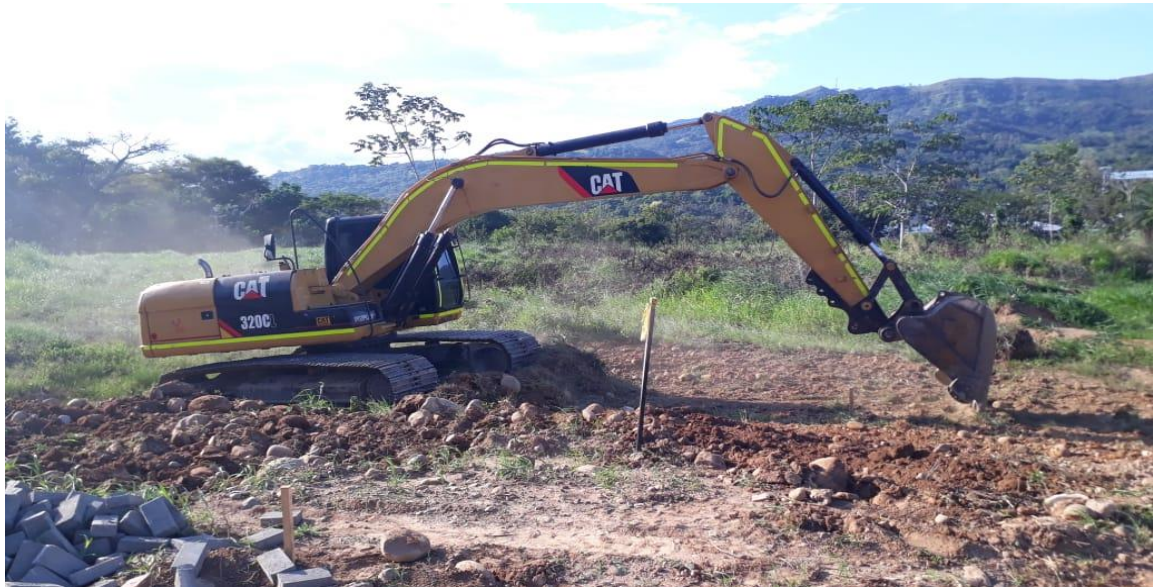
Ilustración 72. ÍTEM: 3.1 Excavación mecánica en material común 0 - 2 m
