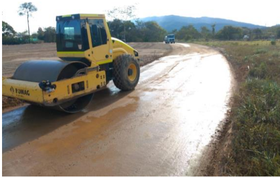
Ilustración 30. Sub base granular Triturada
