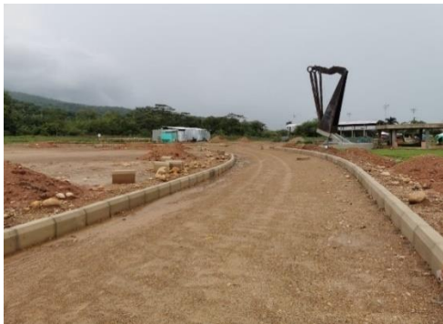
Ilustración 35. Sardinell Prefabricado (0.80 x 0.20 x 0.35).
