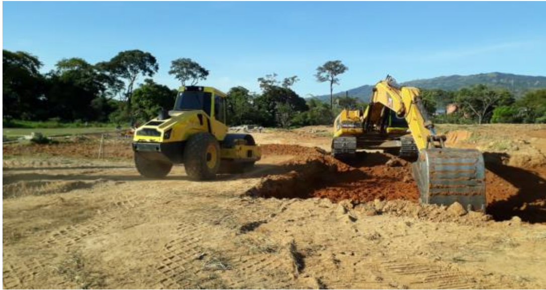
Ilustración 65. ÍTEM: 3.1 Excavación mecánica en material común 0 - 2 m
