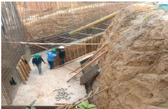
Ilustración 31. Acero de refuerzo en estribo y aleta.
