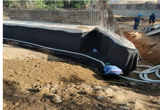
Ilustración 38. Geotextil y Filtro para aliviaderos
