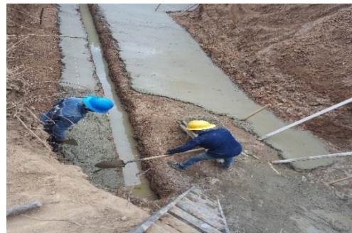
Ilustración 27. Concreto para solado 2000 psi.
