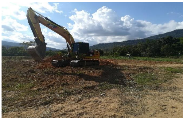
Ilustración 20. Ítem 3 Excavación mecánica.
