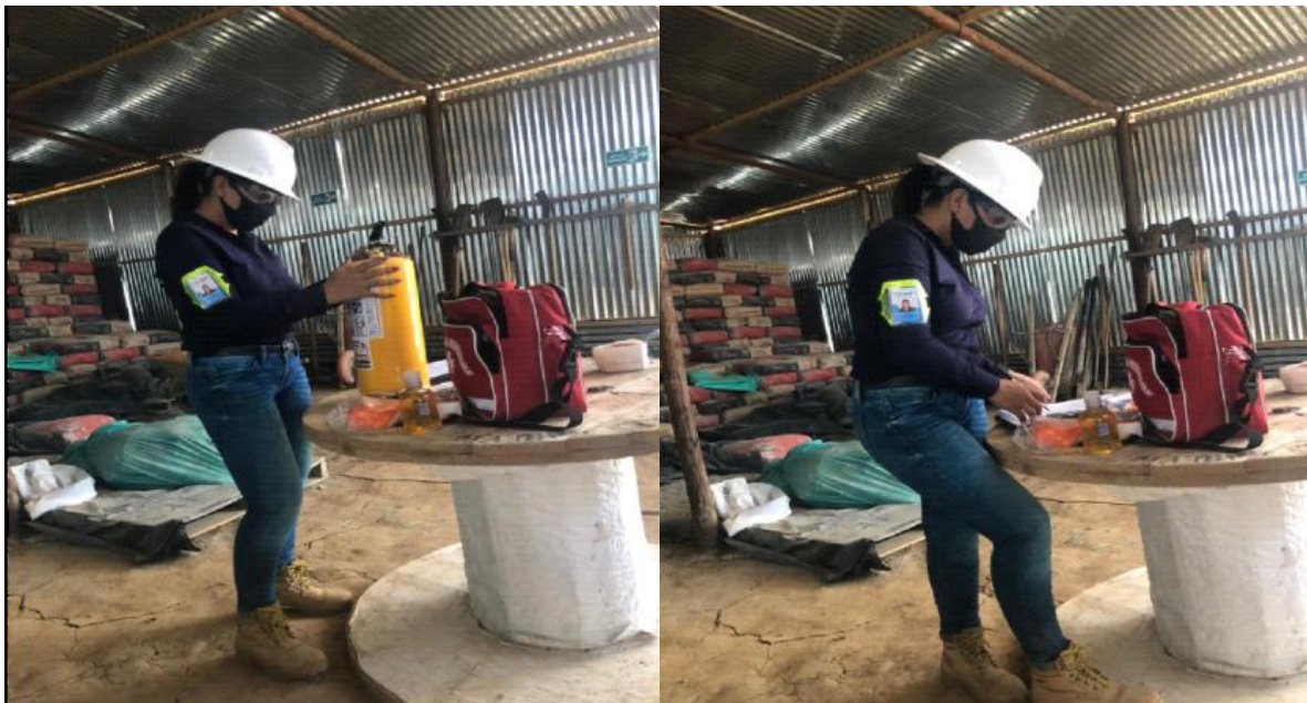
Ilustración 49. Inspección de Extintores y Botiquín de primeros auxilios.
