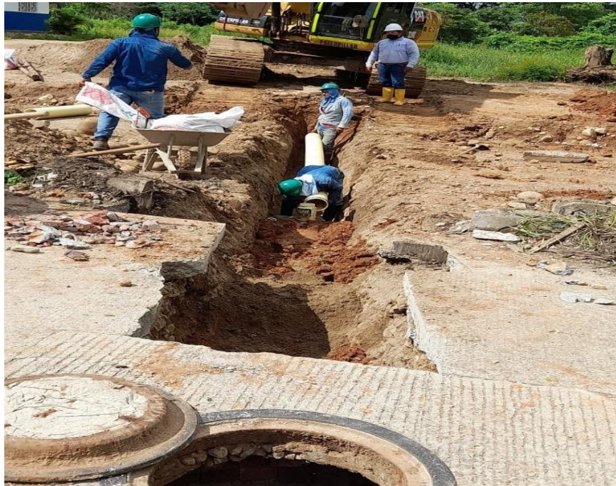
Ilustración 85. ÍTEM: 7.5 Tubería PVC alcantarillado 20", suministro e instalación.
