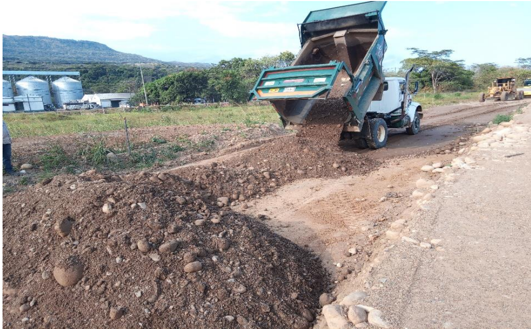
Ilustración 67. ÍTEM: 4.1 Mejoramiento de la subrasante con material crudo de río
