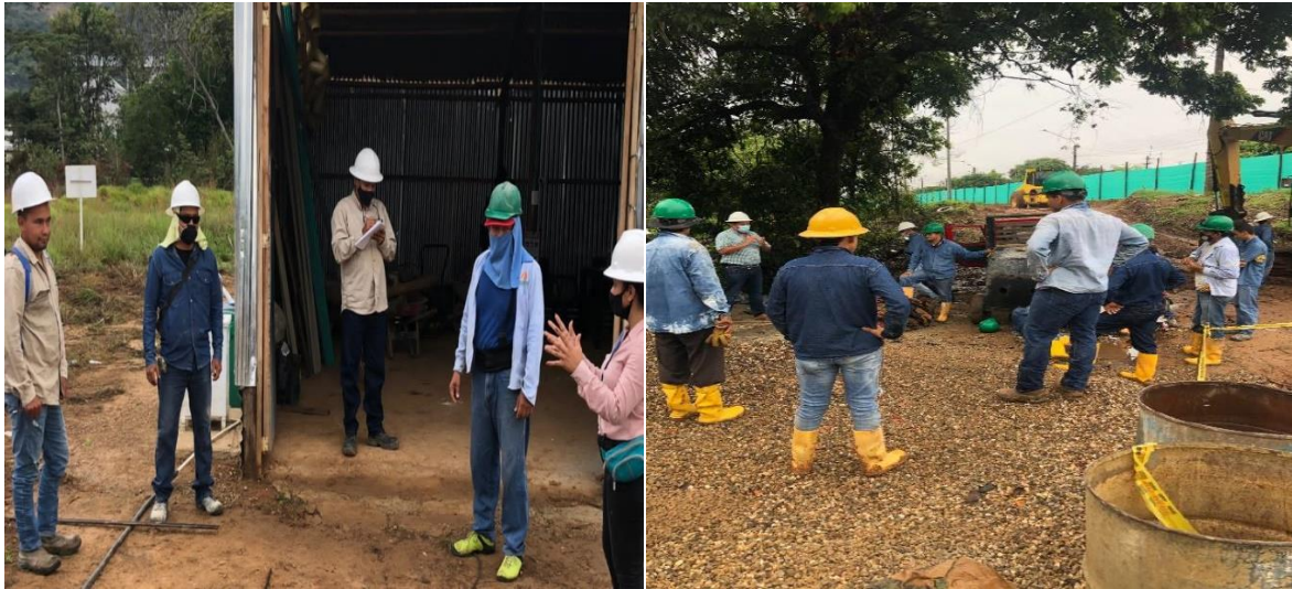
Ilustración 48. Charlas de seguridad al personal en obra.
