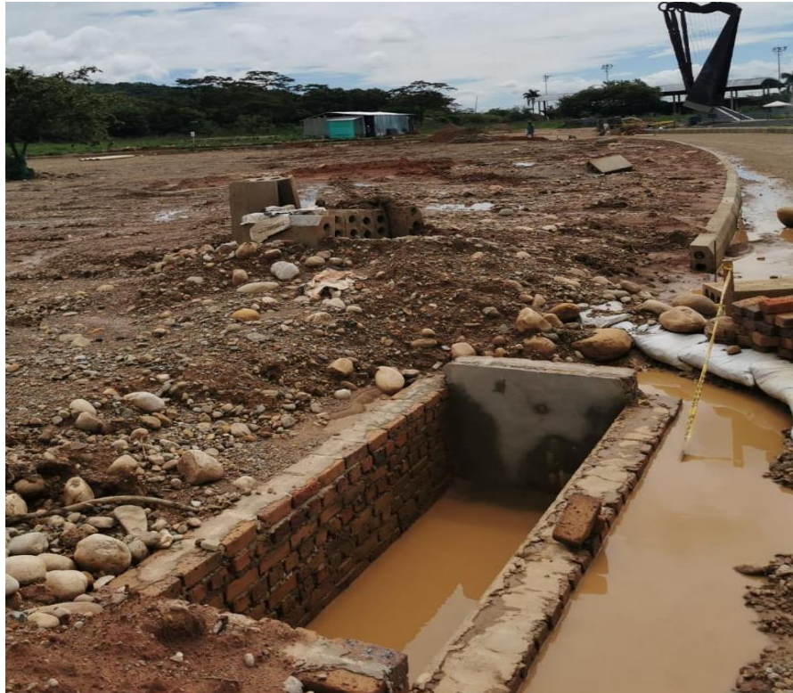
Ilustración 89. ÍTEM: 7.13 Relleno estructural mecánico con material de la excavación compactado.
