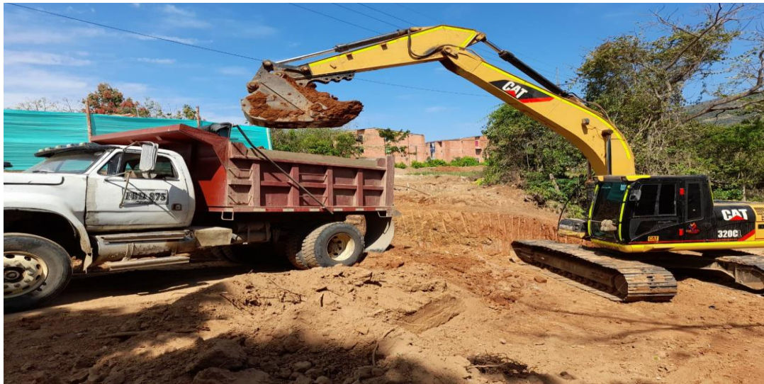
Ilustración 66. ÍTEM: 3.2 Cargue y retiro mecánico de material, con acarreo a 6 Kms Fuente Eli Yohana García. 2021.
