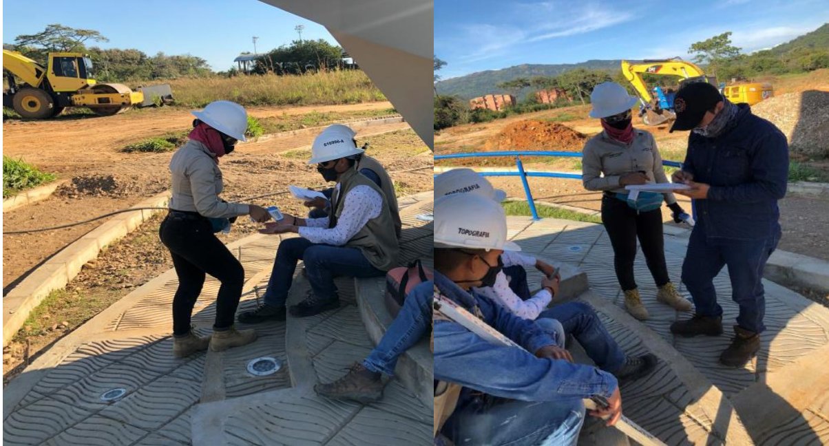
Ilustración 50. Cumplimiento del Protocolo de Bioseguridad en Obra, toma de temperatura y aplicación de alcohol.
