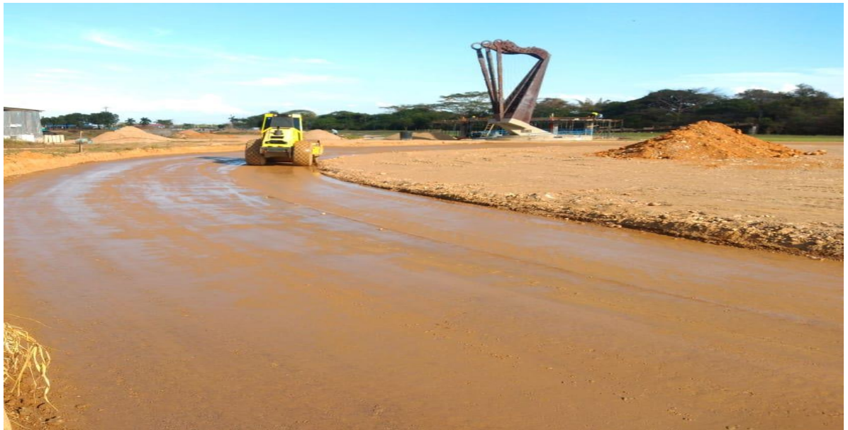
Ilustración 68. ÍTEM: 4.2 Sub base granular triturada.
