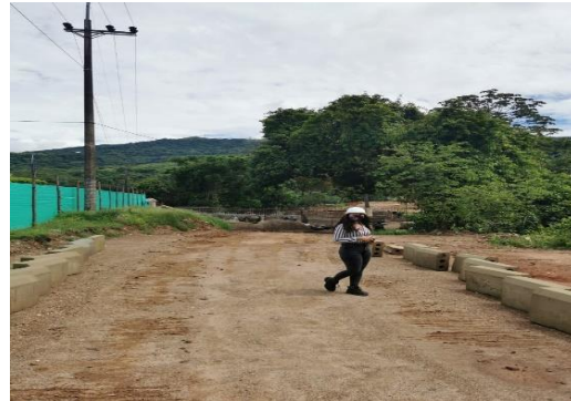
Ilustración 37. TRAMO 3 Sardinell Prefabricado
