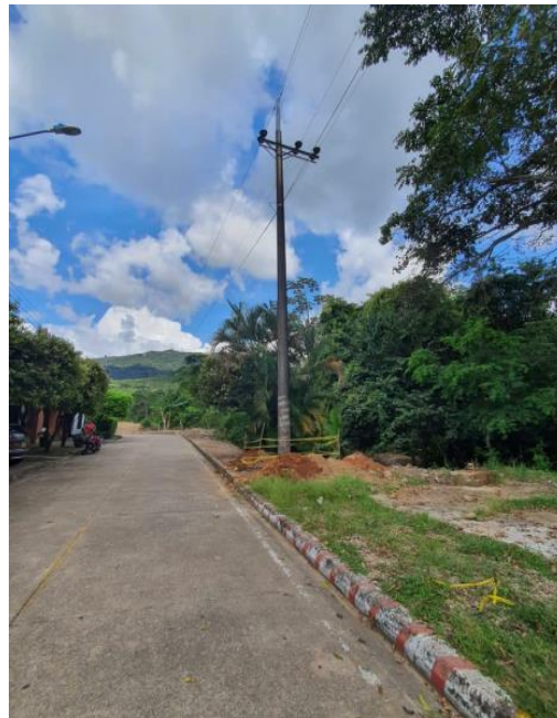
Ilustración 64. ÍTEM: 1.1 Retiro y traslado poste de ferroconcreto de 8 m x 510 kgf.
