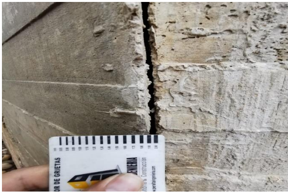
Ilustración 44. Evidencia de juntas de dilatación en aletas del puente.
