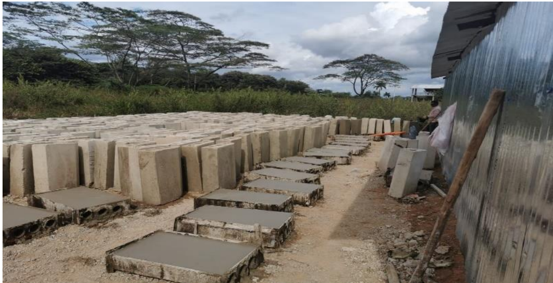
Ilustración 70. ÍTEM: 5.5 Sardinel Prefabricado A - 10 (0.80 x 0.20 x 0.50)
