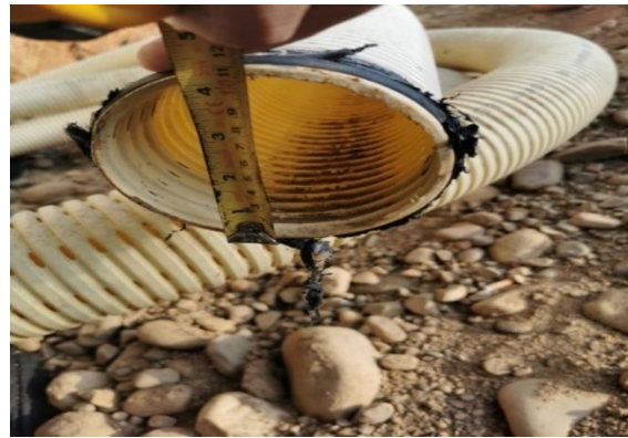
Ilustración 45. verificación Diámetro de la tubería.
