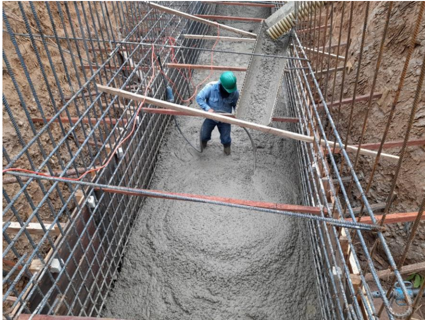
Ilustración 90. ÍTEM: 14.1 Muros o elevaciones estribos, concreto para puentes de resistencia 3000 Psi
