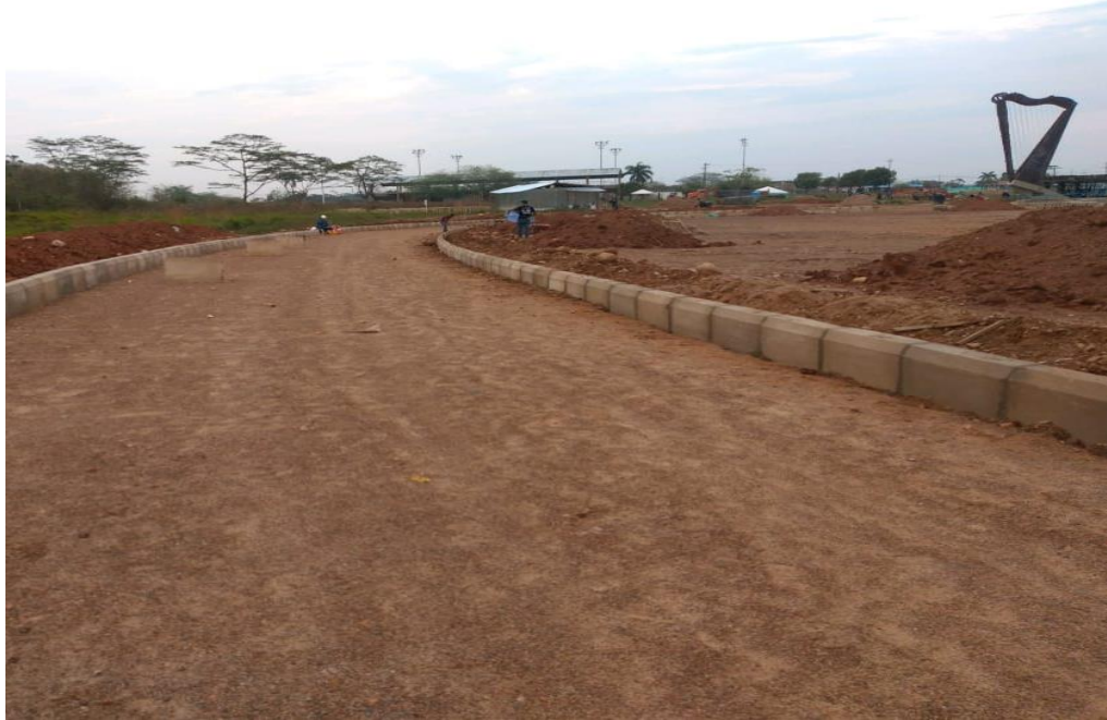
Ilustración 83. ÍTEM: 5.5 Sardinel Prefabricado A - 10 (0.80 x 0.20 x 0.50)
