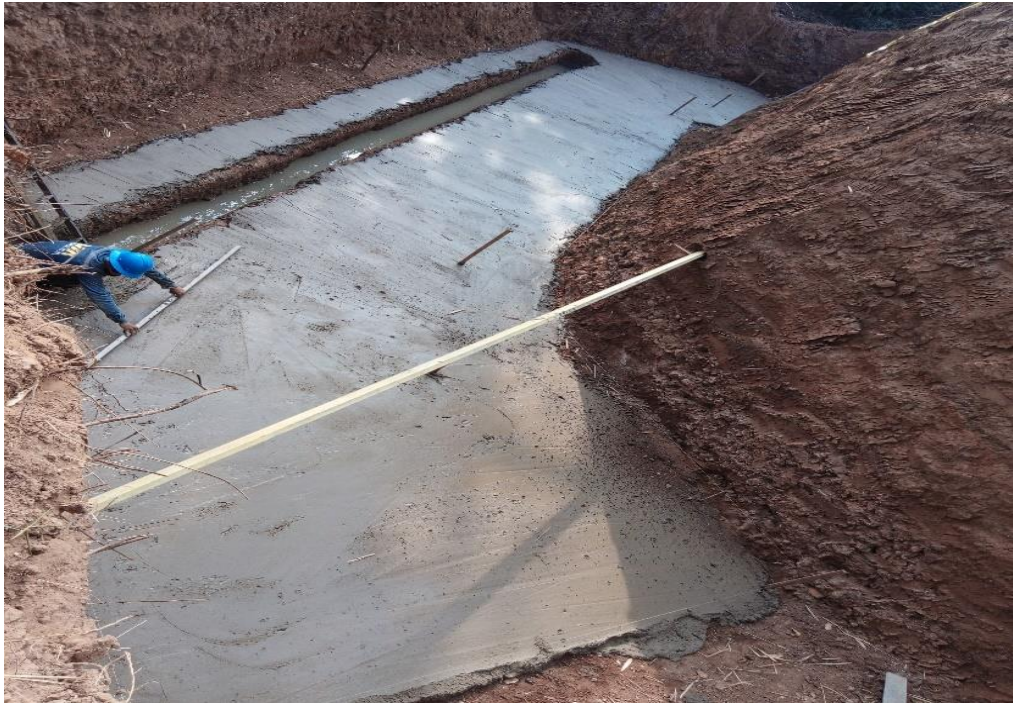
Ilustración 78. ÍTEM: 14.5 Concreto para solado resistencia 140 kg/cm 2 - 2000 psi
