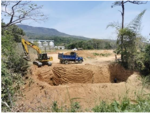
Ilustración 26. Excavación mecánica en material común
