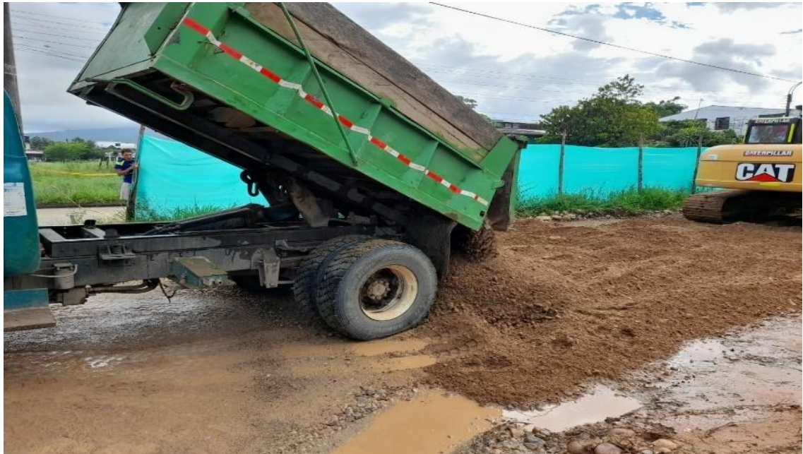
Ilustración 73. ÍTEM: 4.1 Mejoramiento de la subrasante con material crudo de río
