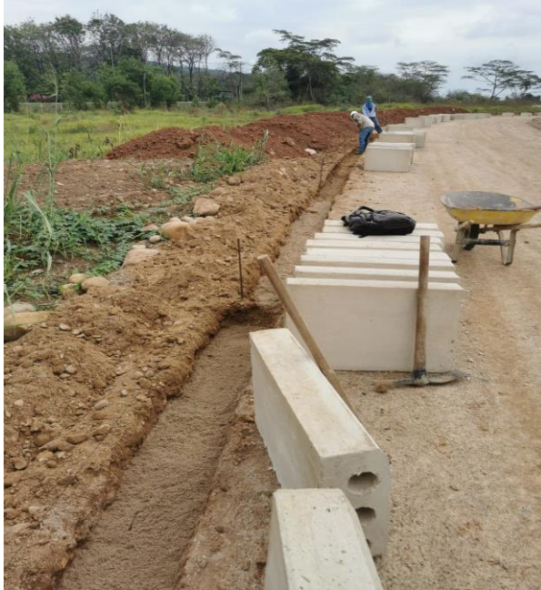
Ilustración 79. ÍTEM: 5.5 Sardinel Prefabricado A - 10 (0.80 x 0.20 x 0.50)
