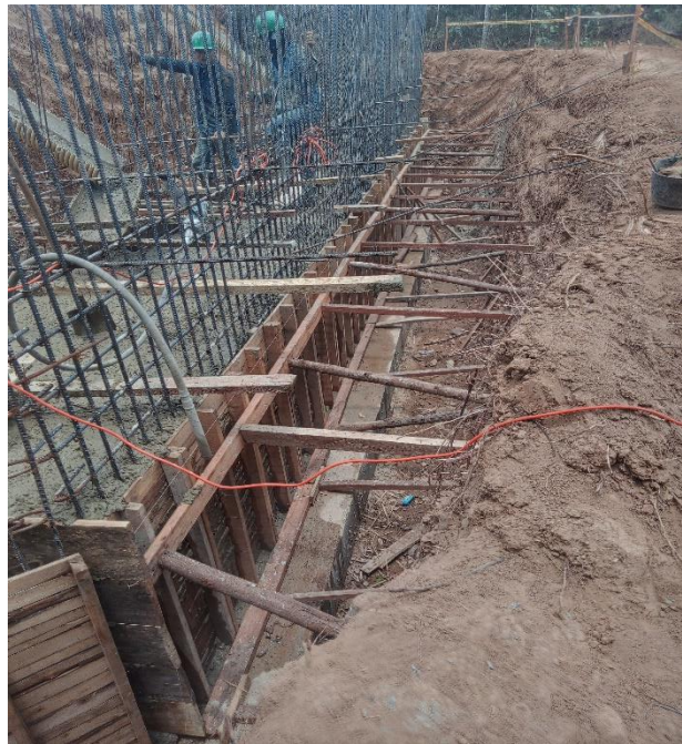
Ilustración 81. ÍTEM: 14.1 Muros o elevaciones estribos, concreto para puentes de resistencia 3000 Psi
