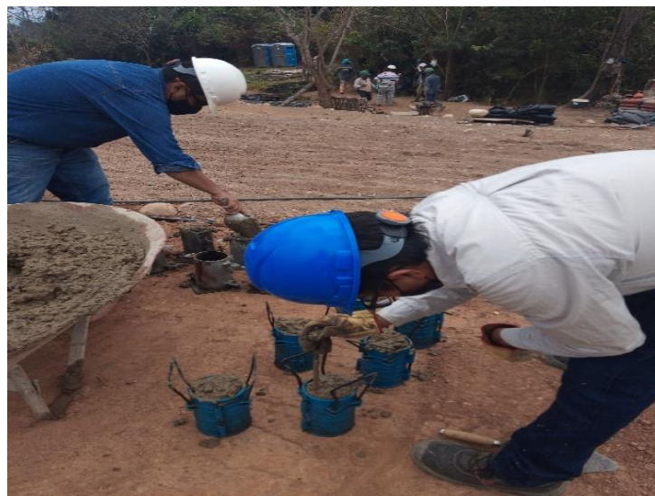
Ilustración 54. Toma de muestras de concreto.
