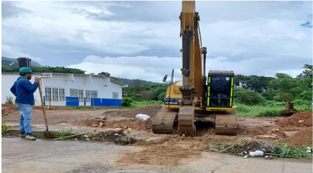
Ilustración 88. ÍTEM: 7.12 Relleno en arena lavada apisonada para atraque de la tubería con transporte.
