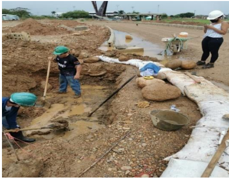
Ilustración 34. Sumidero lateral SL-200 en mampostería
