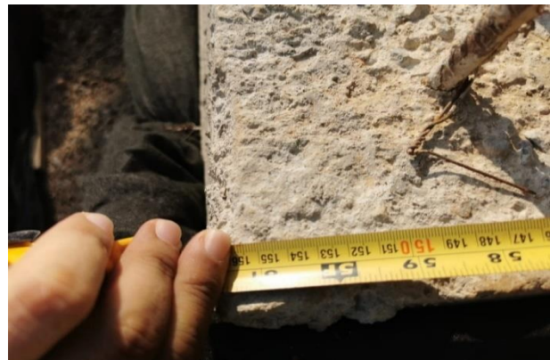
Ilustración 47. verificación de espaciamiento en aletas del puente.
