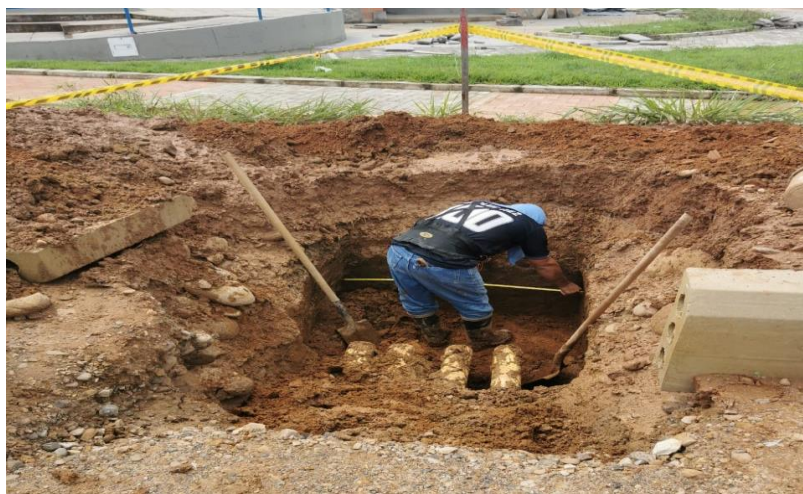
Ilustración 86. ÍTEM: 7.6 Tubería PVC alcantarillado 8", suministro e instalación.
