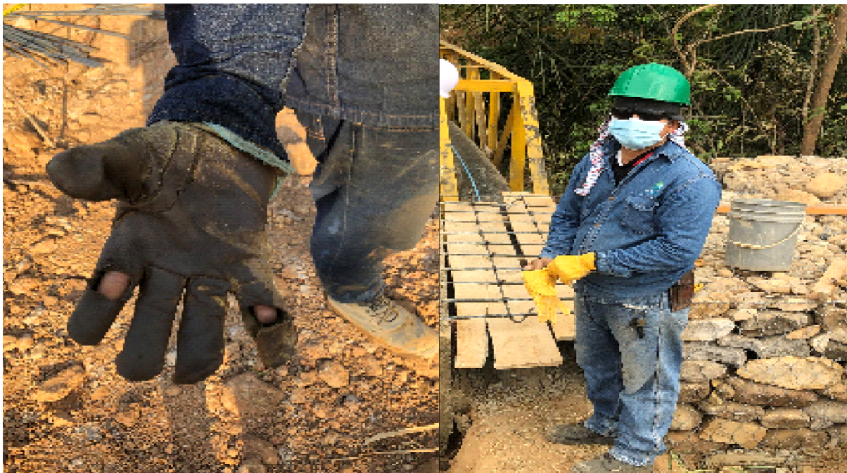
Ilustración 51. Uso de Elementos de Protección Personal en Actividades de Obra.
