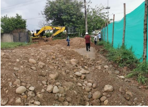
Ilustración 36. Mejoramiento de la subrasante TRAMO 3
