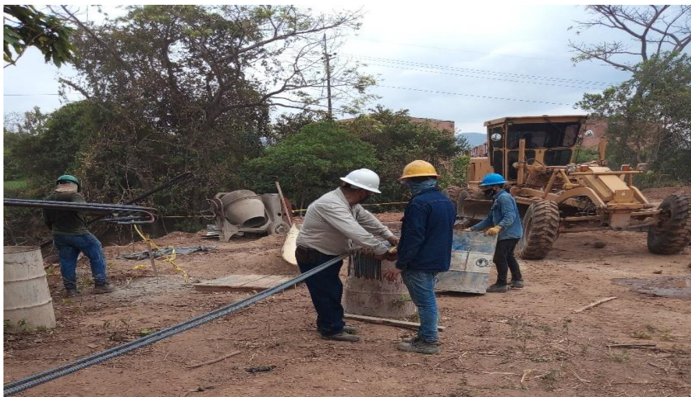
Ilustración 77. ÍTEM: 13.2 Acero de Refuerzo Grado 60.
