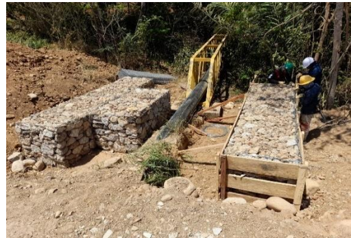
Ilustración 32. Protección en gaviones a tubería de acueducto.
