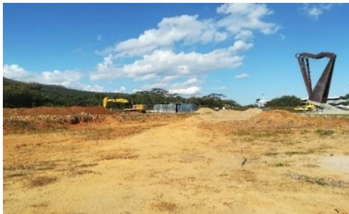
Ilustración 25. Excavación mecánica en material común
