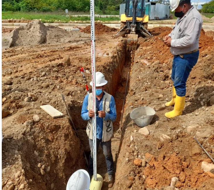
Ilustración 87. ÍTEM: 7.7 Tubería de Polietileno PE 100 PN-10 de \varnothing=90 mm =3"
