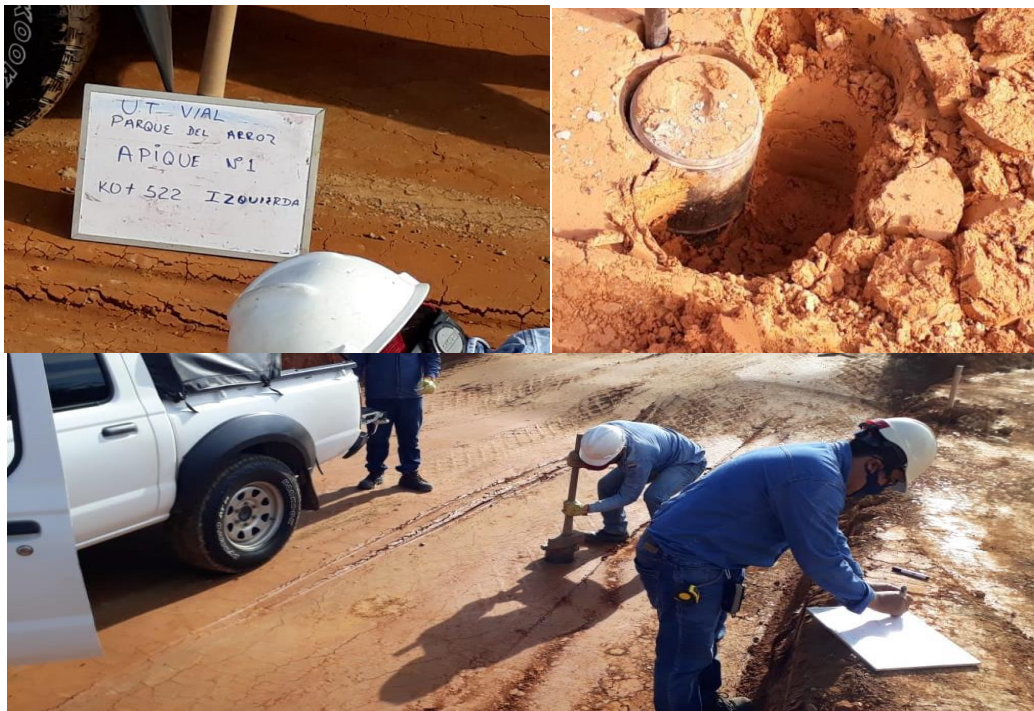
Ilustración 57. Toma de muestra CBR.
