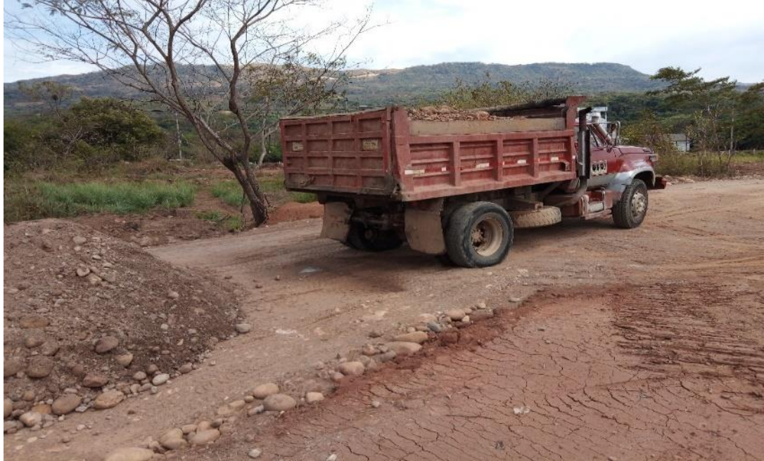
Ilustración 74. ÍTEM: 4.3 Sobrecarros o transporte de material Petreo (via pavimentada).
