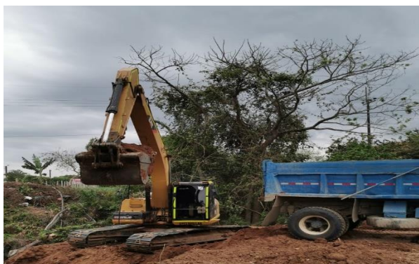
Ilustración 23. Cargue y retiro mecánico de material.
